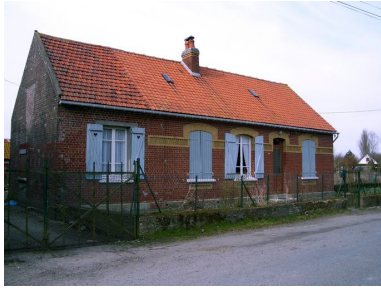
Vue générale de la maison. Phot. Inès Guérin IVR22_20058005167NUCA
