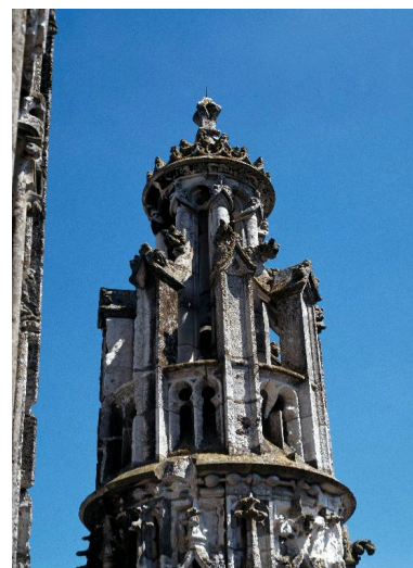
Bras sud du transept : détail d'un pinacle. Phot. Thierry Lefébure IVR22_19976000435XA
