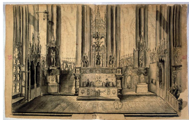
L'intérieur du sanctuaire, dessin de 1730 (BM Beauvais, coll. Bucquet-Aux-Cousteaux, tome 23). Phot. Irwin Leullier IVR22_19996001958XA
