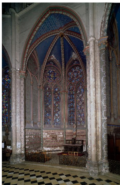
Vue intérieure de la chapelle axiale.
