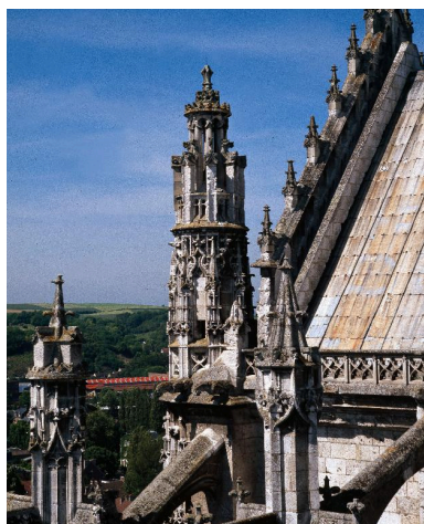
Sommet du bras sud du transept, vu de l'est. Phot. Thierry Lefébure IVR22_19976000438XA
