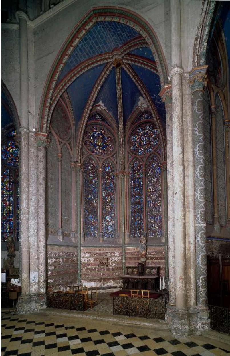
Vue intérieure de la chapelle axiale.
