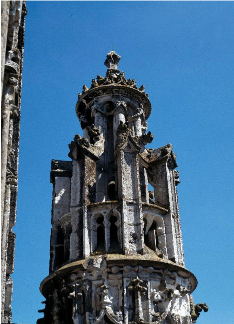
Bras sud du transept : détail d'un pinacle.
