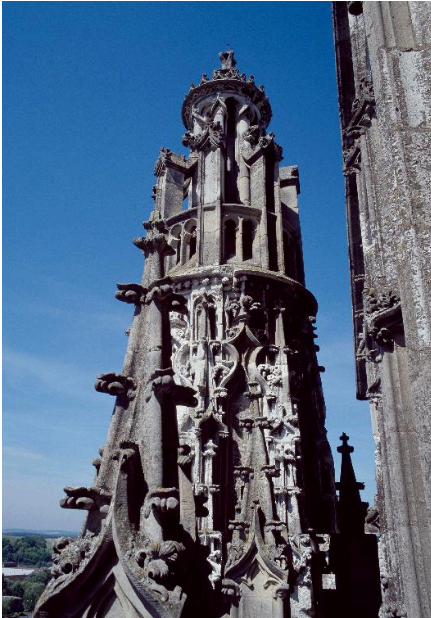
Détail d'un pinacle du bras sud du transept.
