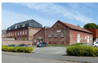
Ancienne salle de patronage du pensionnat Saint-Joseph.
