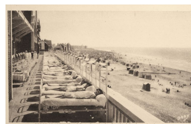
Élévation antérieure donnant sur la plage, terrasse de cure découverte s'étendant au-devant du 2e étage, vue en enfilade avec des malades allongés sur leur lit. Carte postale, 1er quart 20e siècle (coll. part.). Phot. Bouvet Hubert
