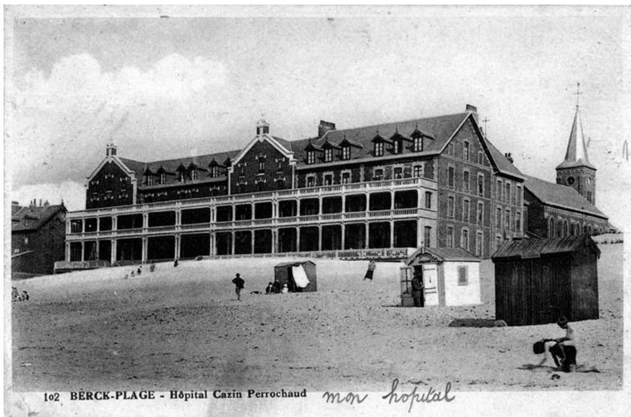
Elévation sur la plage, état après la construction des galeries de cure en béton armé, vue générale prise de trois-quarts droit. Carte postale, vers 1925 (coll. part.).
