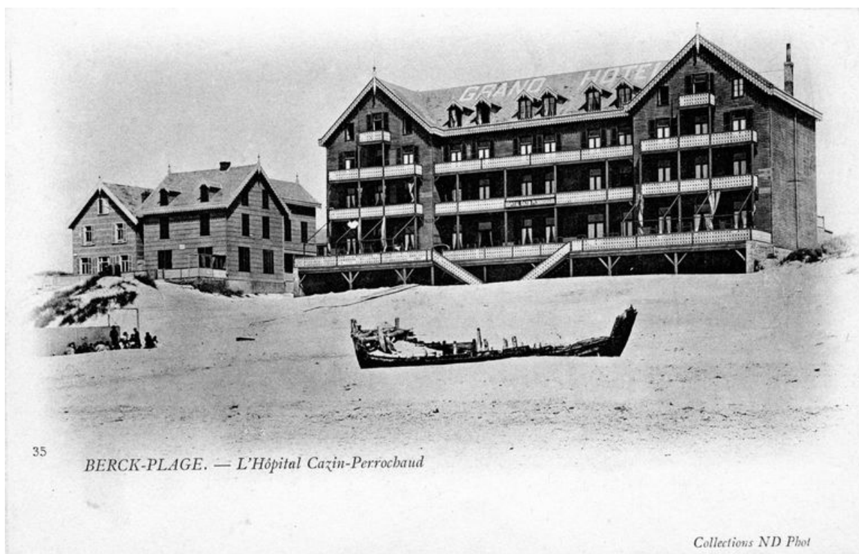
Elévation antérieure donnant sur la plage de l'ancien Grand Hôtel, état avant la construction du bâtiment de la communauté religieuse sur son flanc sud, vue de trois-quarts droit. Carte postale, 1er quart 20e siècle (coll. part.).
