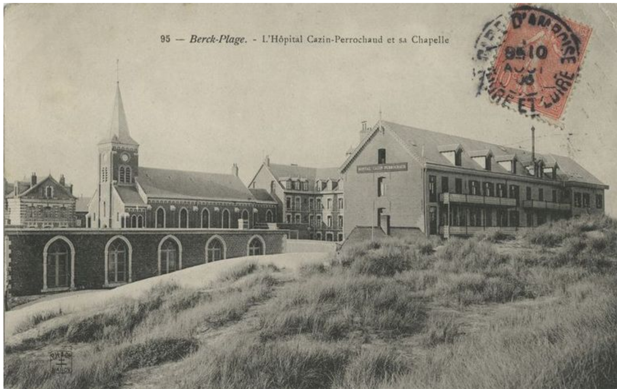
Elévation postérieure, vue générale prise de trois-quarts droit. Carte postale, 1er quart 20e siècle (coll. part.).
