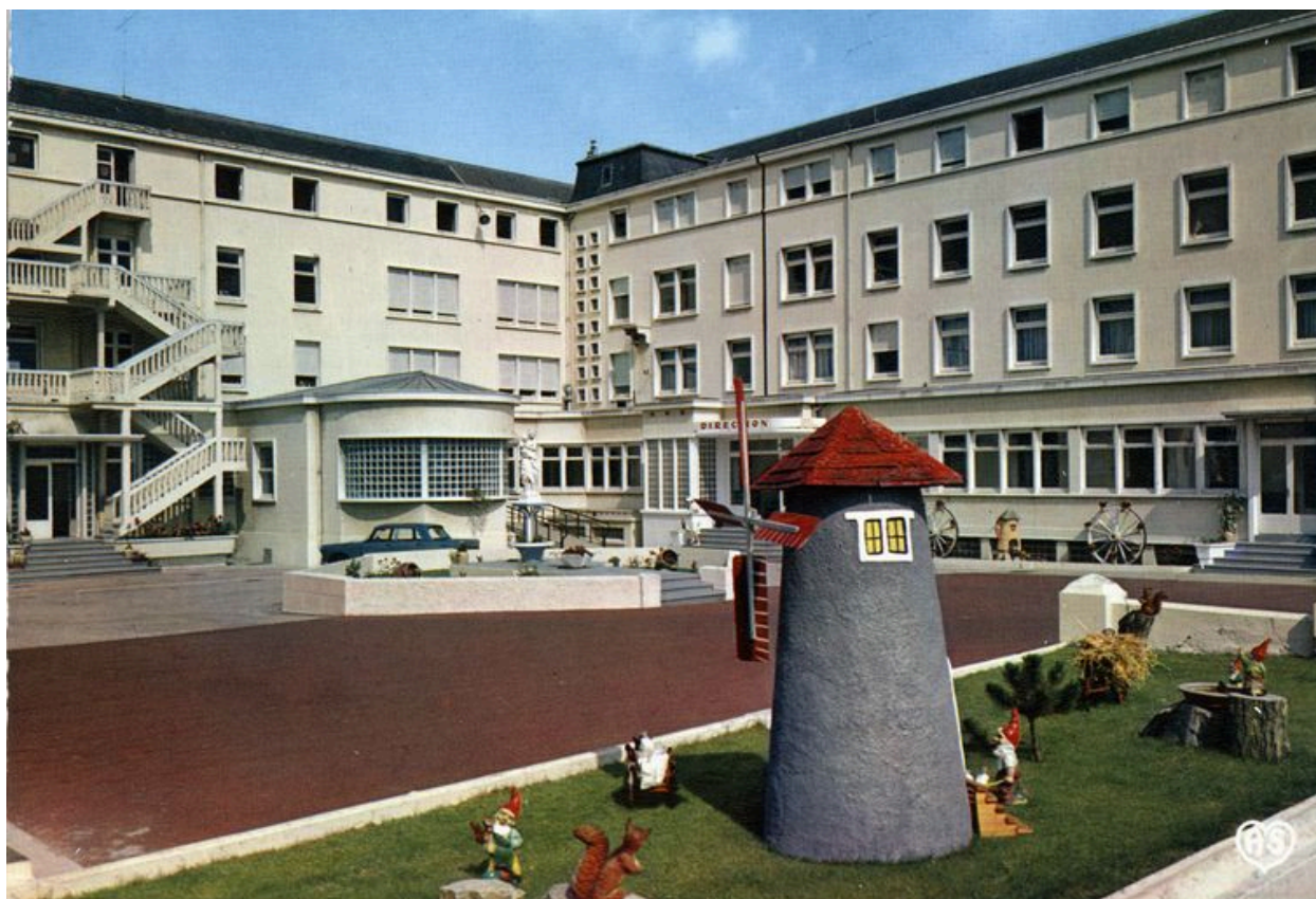
Elévation postérieure du corps de logis principal, détail de la partie droite et extrémité proximale de l'aile nord après la restauration générale et les profonds remaniements consécutifs à la seconde guerre mondiale. Carte postale, 3e quart 20e siècle (coll. part.).
