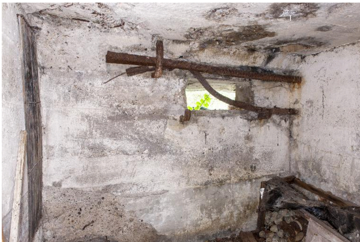
Salle qui occupe la partie gauche de la casemate, vue vers la paroi antérieure ou tournée vers le front.
