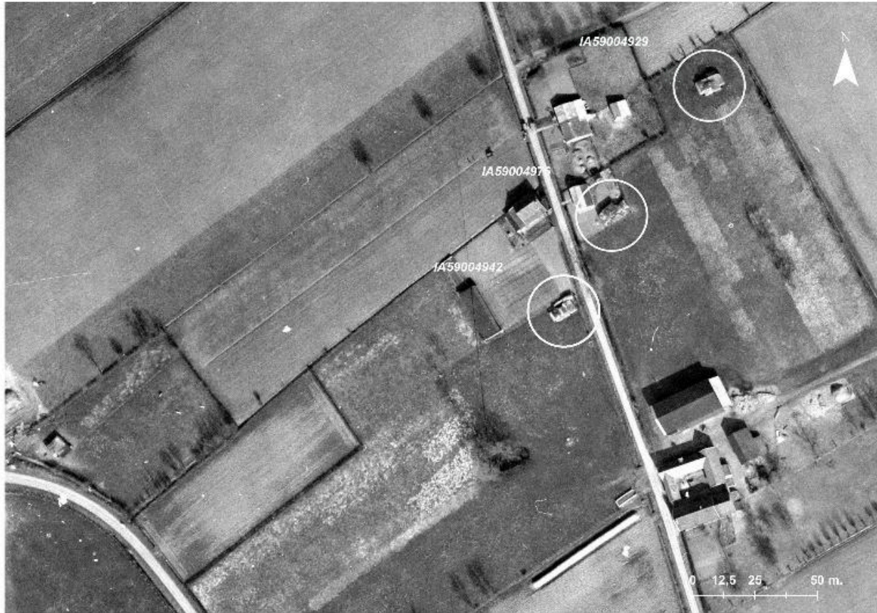
Position de l'édifice (cercle du milieu) sur une photographie aérienne du 13/03/1965 (IGN, Geoportail).
