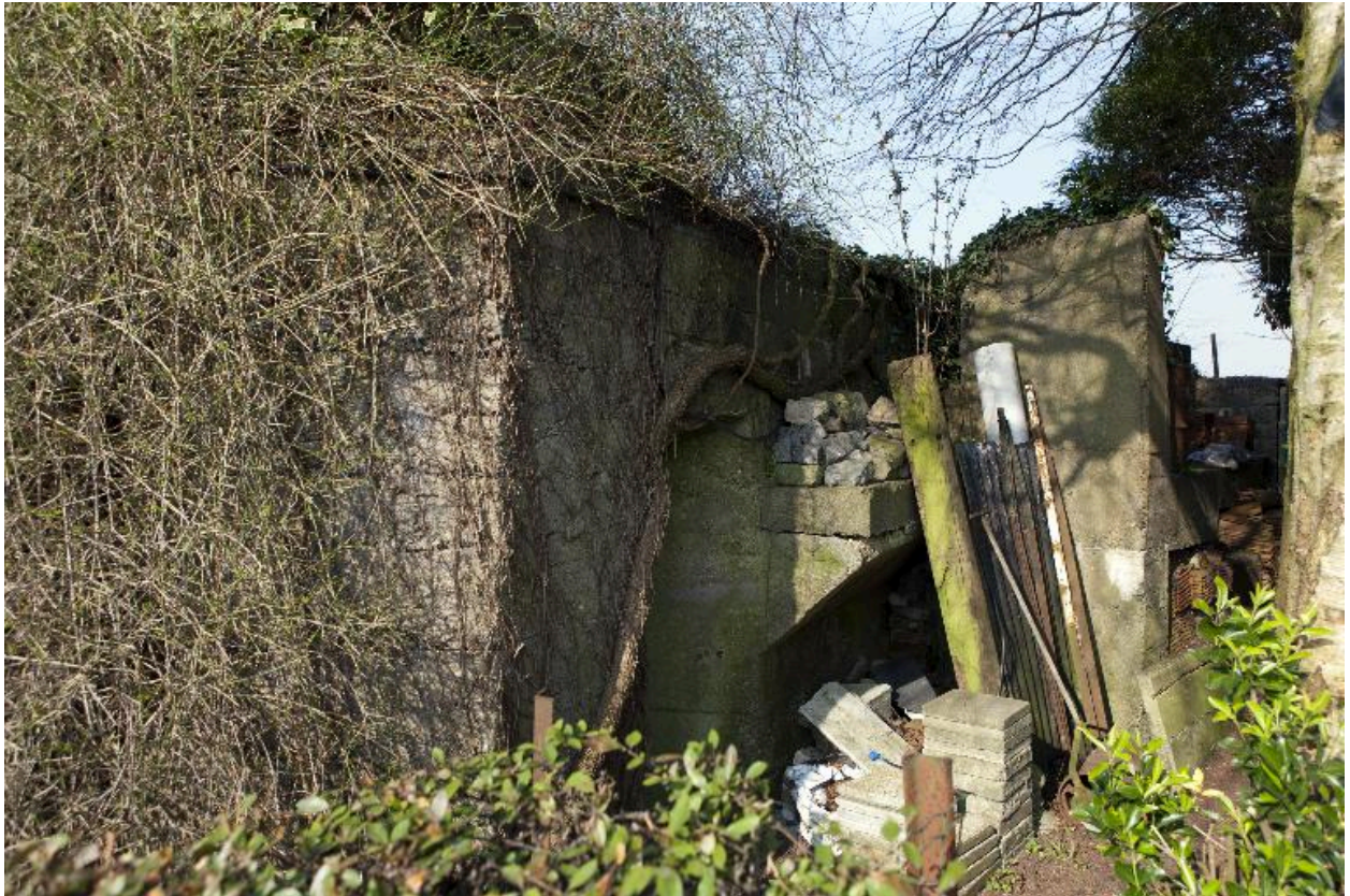
Elévation postérieure ou tournant le dos au front avec la banquette d'infanterie qui règne le long de la partie gauche de cette élévation, vue prise en enfilade depuis le flanc droit de la casemate.
