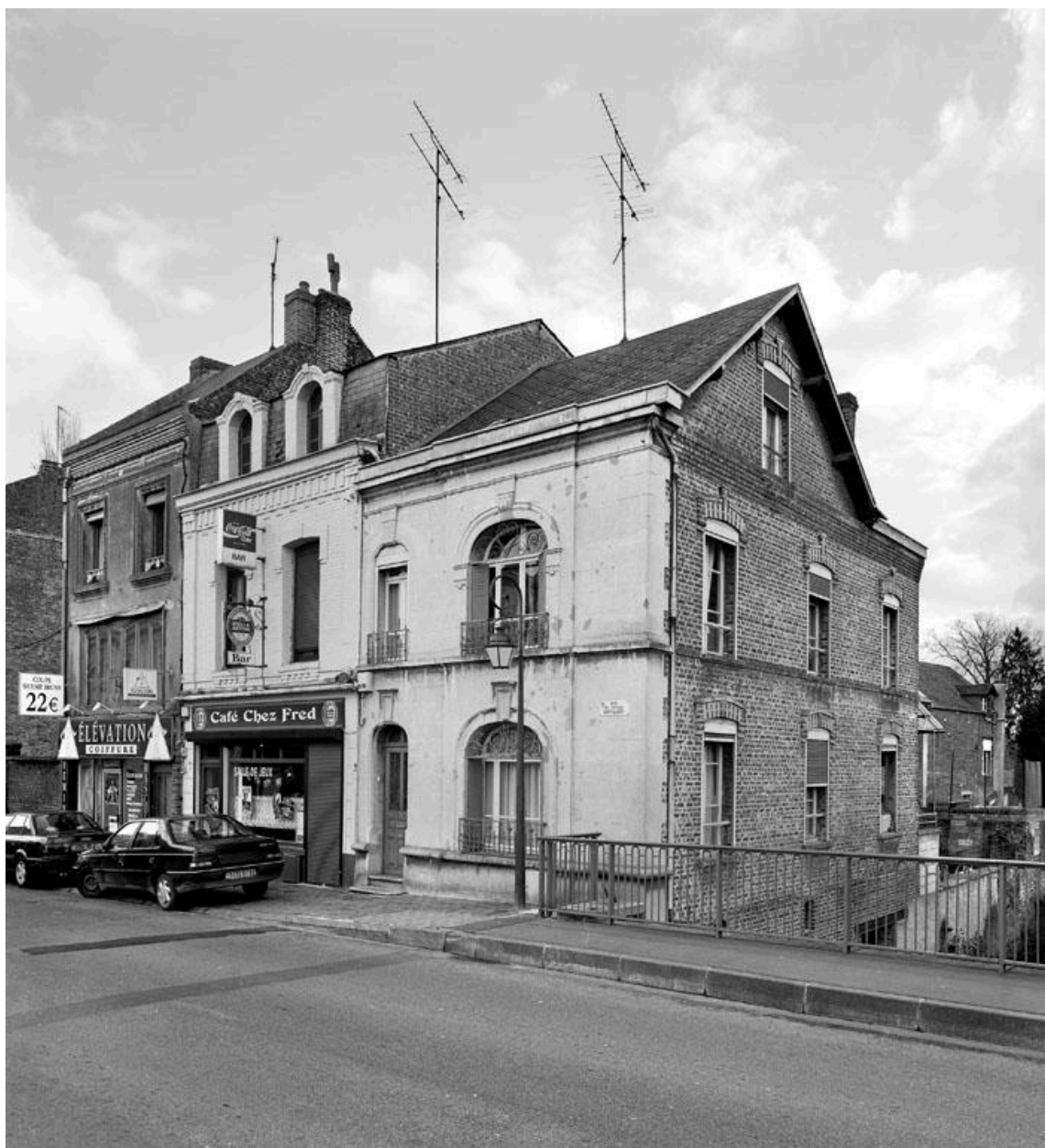
Vue des façades sur rue, depuis le Grand Pont.
