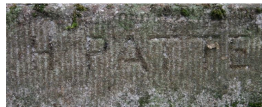
Signature de l'entrepreneur H. Patte, sur la stèle principale. Phot. Caroline Vincent IVR22_20068000645NUCA
