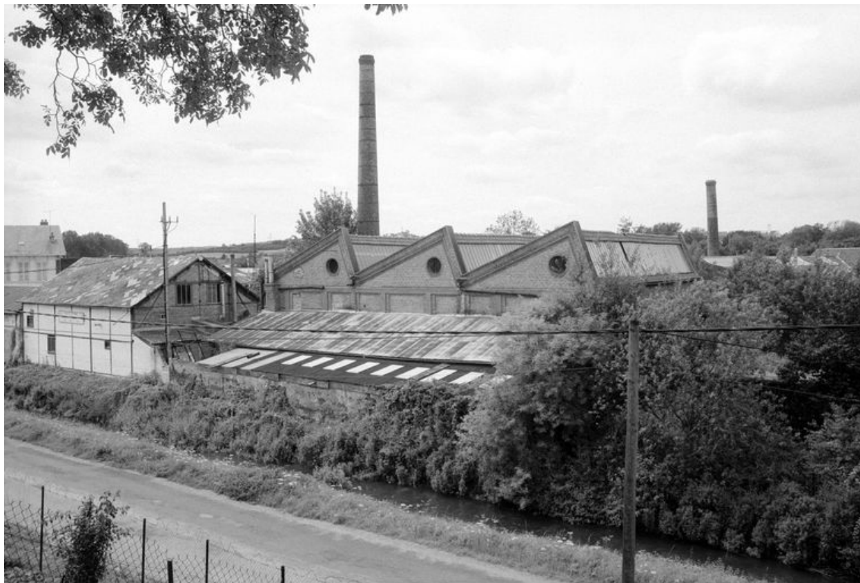
Vue partielle, flanc sud-est.
