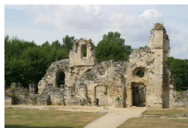
Vue partielle du bâtiments des convers. Phot. Inès Guérin IVR22_20030202055NUCA
