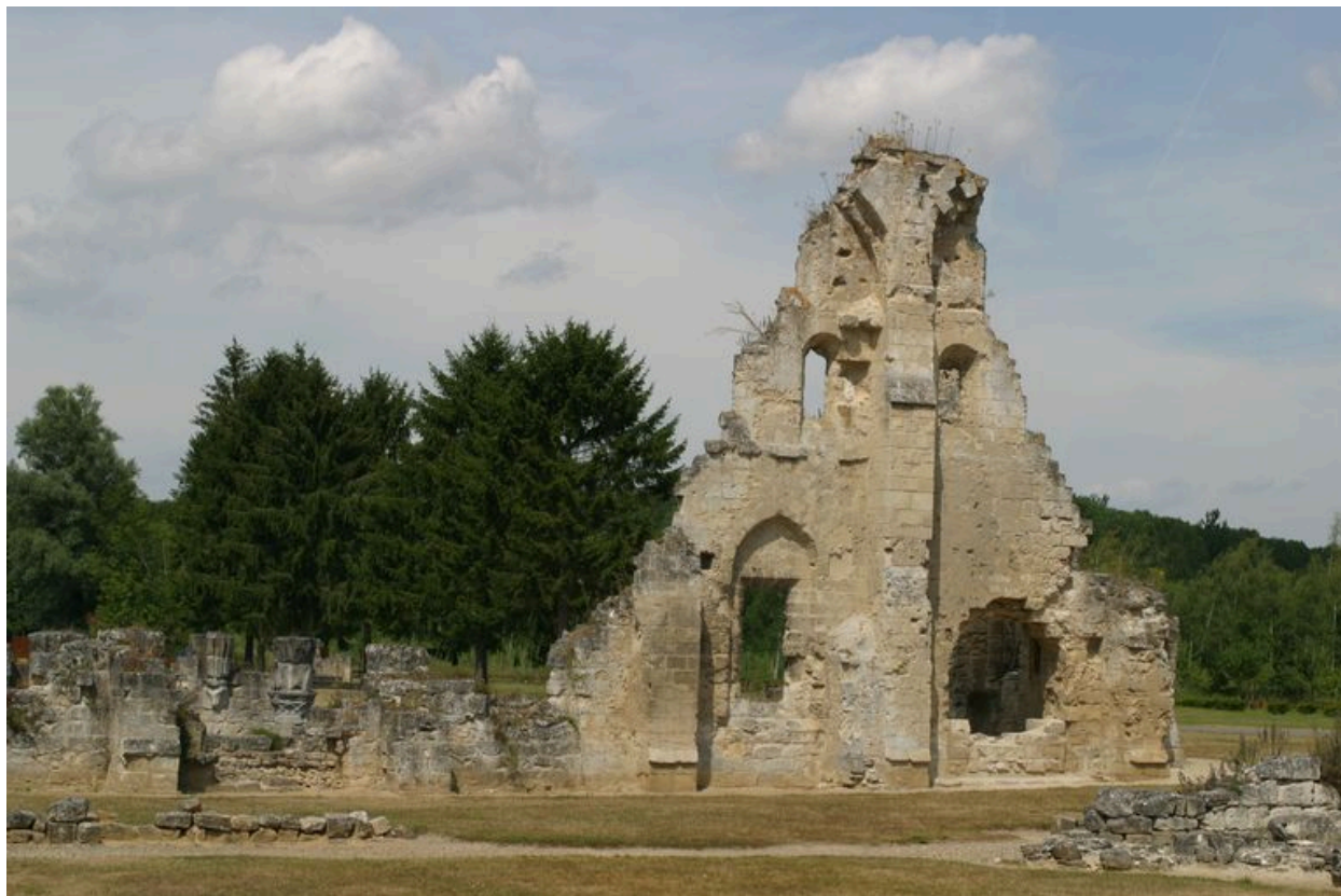
Vue partielle du bâtiments des convers.
