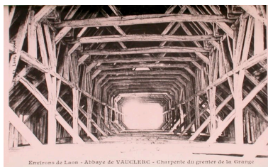
Vue ancienne de la charpente du grenier de la grange (AD Aisne : 2 Fi Bouconville-Vauclair 40). Phot. Inès Guérin IVR22_20030202063NUCAB
