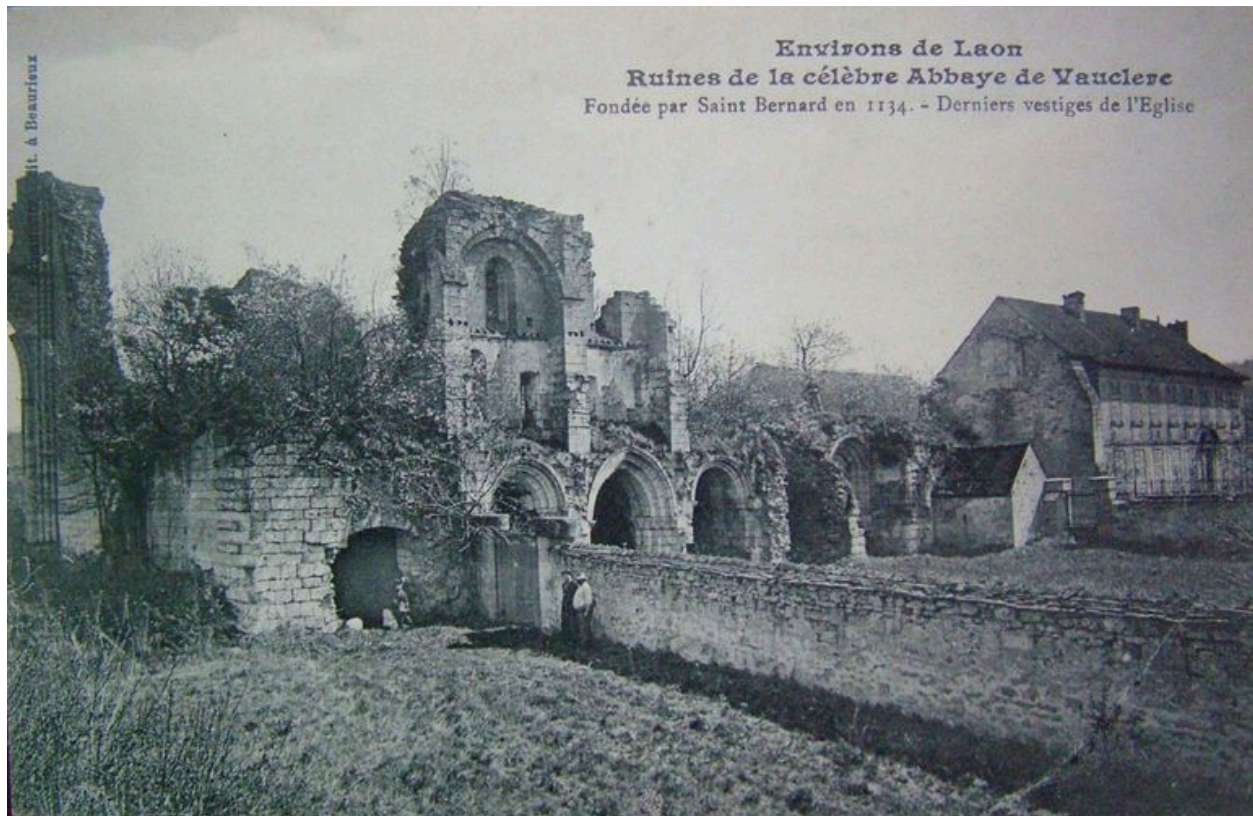
Vue de l'église en ruines (coll. part).
