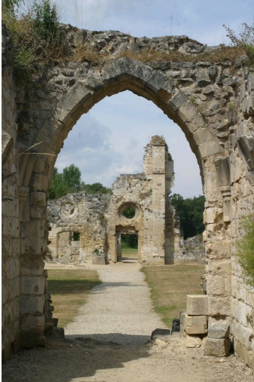
Vue sur le bâtiment des convers depuis la salle des moines.
