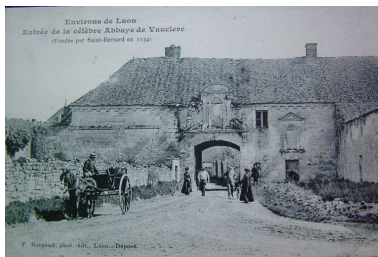
Vue ancienne de l'entrée de l'abbaye (coll. part). Phot. Inès Guérin IVR22_20030202748NUCAB
