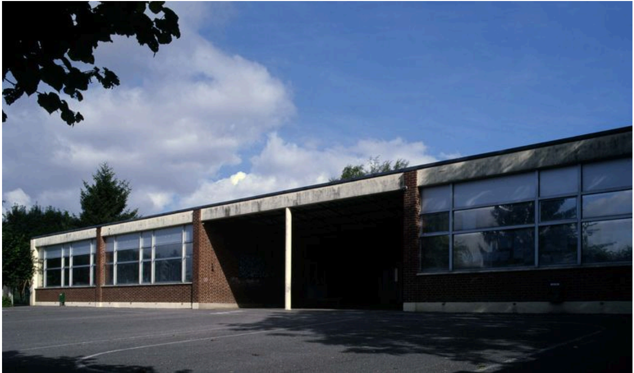
Pernois, groupe scolaire, Joseph Andrieu architecte, 1957.
