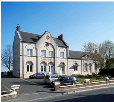
Bettencourt-Saint-Ouen, mairie et école primaire, C. Masse architecte, 1860, et Caron architecte, 1896. Phot. Marie-Laure Monnehay-Vulliet IVR22_20108000144XA
