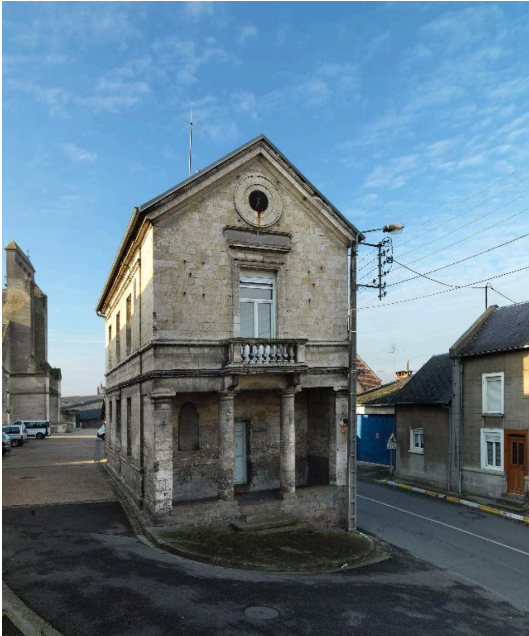
Flixecourt, ancienne mairie, Marest architecte, 1827.
