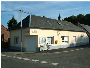
Vauchelles-lès-Domart, mairie, 1874 et 1976. Phot. Frédéric Fournis IVR22_20108001695NUCA
