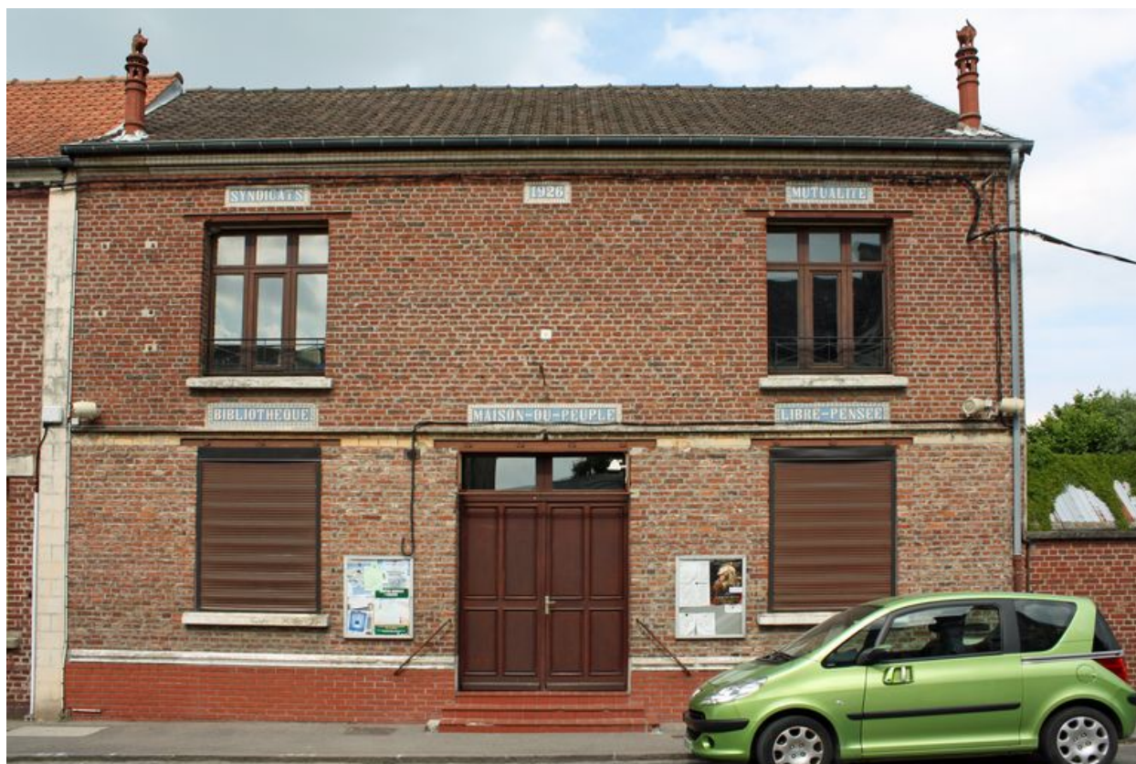
Saint-Ouen, ancienne maison du peuple, 1926.
