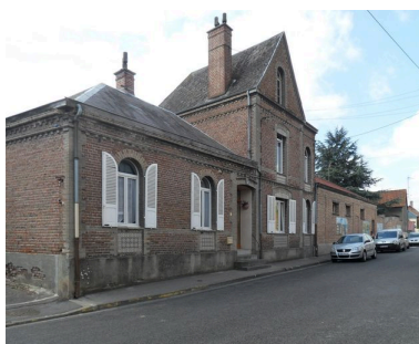
Saint-Ouen, école primaire Notre-Dame, avant 1914. Phot. Isabelle Barbedor IVR22_20108001501NUCA
