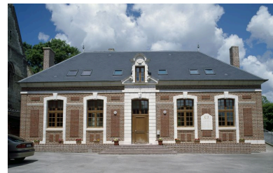
Bouchon, mairie, Emile Ricquier architecte, 1875. Phot. Marie-Laure Monnehay-Vulliet IVR22_20098000163XA
