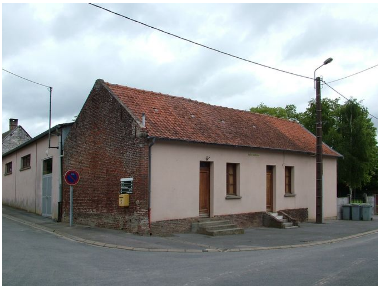
Pernois, ancienne école primaire de filles et mairie, 1re moitié du 19e siècle.
