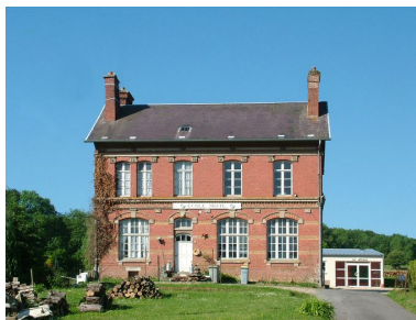
Franqueville, mairie, Emile Ricquier architecte, 1903. Phot. Frédéric Fournis IVR22_20108001789NUCA
