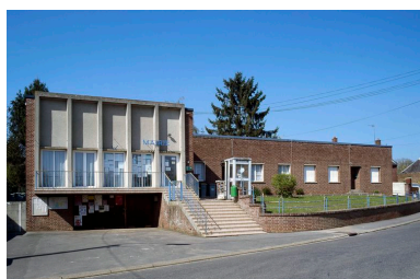
Pernois, mairie, Joseph Andrieu architecte, 1957. Phot. Marie-Laure Monnehay-Vulliet IVR22_20098000270XA
