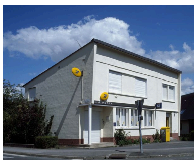
Canaples, poste, 1955 et vers 1970. Phot. Marie-Laure Monnehay-Vulliet IVR22_20098000223XA
