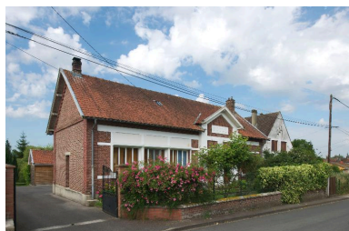
L'Étoile, ancienne école maternelle des Moulins-Bleus, 1934. Phot. Thierry Lefébure IVR22_20128000331NUC4A
