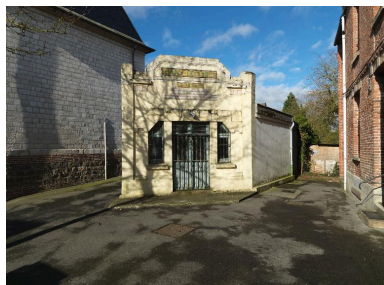
Saint-Ouen, bains-douches, 1934. Phot. Thierry Lefébure IVR22_20148000046NUC2A
