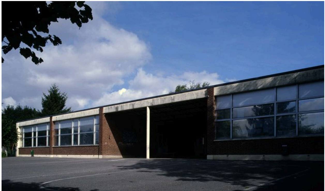
Pernois, groupe scolaire, Joseph Andrieu architecte, 1957.
