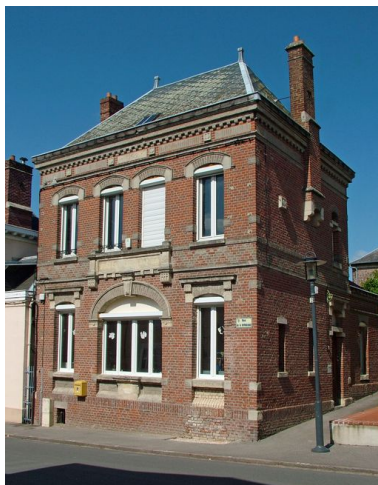
Saint-Ouen, ancienne poste, Anatole Bienaimé architecte, 1902. Phot. Bertrand Fournier IVR22_20098005823NUCA
