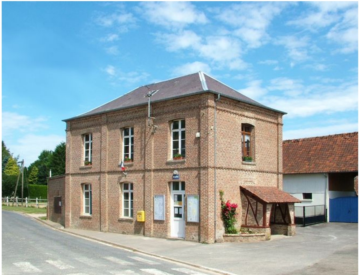
Fransu, mairie et école primaire, Jean-François Fauvel architecte, 1856.
