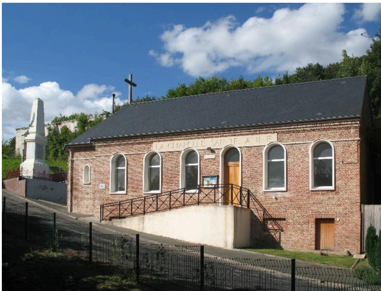
L'Étoile, ancienne école primaire de garçons et mairie, LOuis Henry Antoine architecte (agrandissement), 1867.
