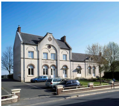
Bettencourt-Saint-Ouen, mairie et école primaire, C. Masse architecte, 1860, et Caron architecte, 1896. Phot. Marie-Laure Monnehay-Vulliet IVR22_20108000144XA
