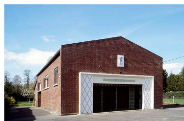
Ribeaucourt, salle des fêtes, Louis Douillet architecte, 1963. Phot. Marie-Laure Monnehay-Vulliet IVR22_20108000120XA
