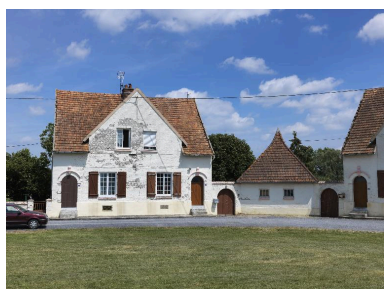
Maison jumelle (42-44, rue du Château). Phot. Thierry Lefébure IVR22_20158000539NUC2A
