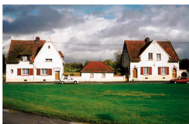
34 à 40 Grande Rue à Canisy. Phot. Gilles-Henri Bailly IVR22_20158005468NUCA
