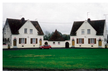
38 à 44 Grande Rue à Canisy. Phot. Gilles-Henri Bailly IVR22_20158005469NUCA
