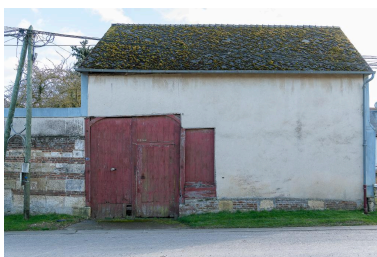
Grange sur rue avec entrée charretière, n°35 Grande Rue, vue depuis le nord. Phot. Marc Kérignard IVR32_20226000058NUCA
