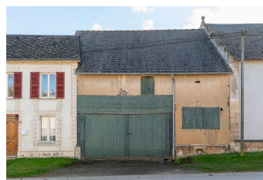
Ancien atelier de serger (?), n°31 Grande Rue, vue depuis le nord. Phot. Marc Kérignard IVR32_20226000055NUCA
