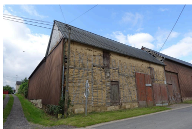
Grange de la ferme au n°41 Grande Rue, vue depuis le nord-est. Phot. Lucile Chamignon IVR32_20226005005NUCA
