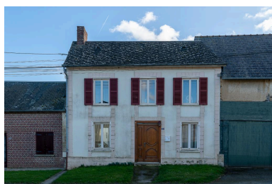
Ancien commerce (?), n°31 Grande Rue, vue depuis le nord. Phot. Marc Kérignard IVR32_20226000051NUCA
