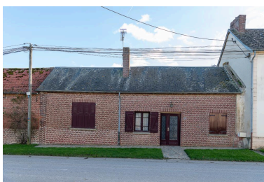
Ancien commerce, n°29 Grande Rue, vue depuis le nord. Phot. Marc Kérignard IVR32_20226000052NUCA
