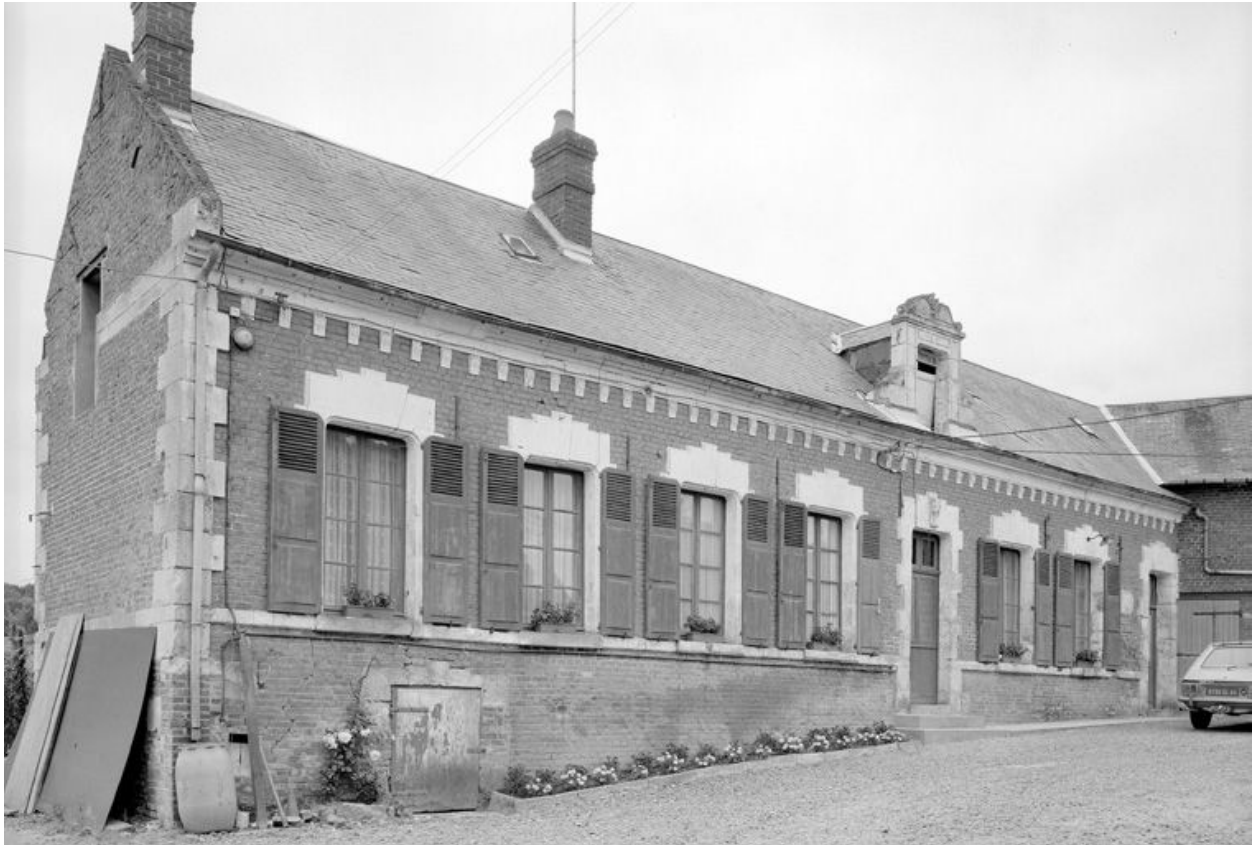
Logis. Elévation antérieure.
