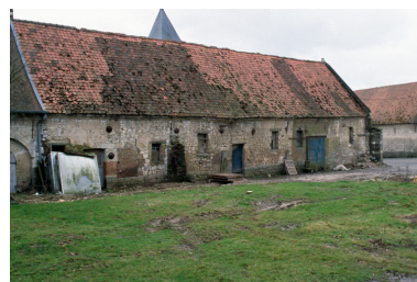
Anciennes écuries (?) Phot. Irwin Leullier IVR22_20008000117ZA
