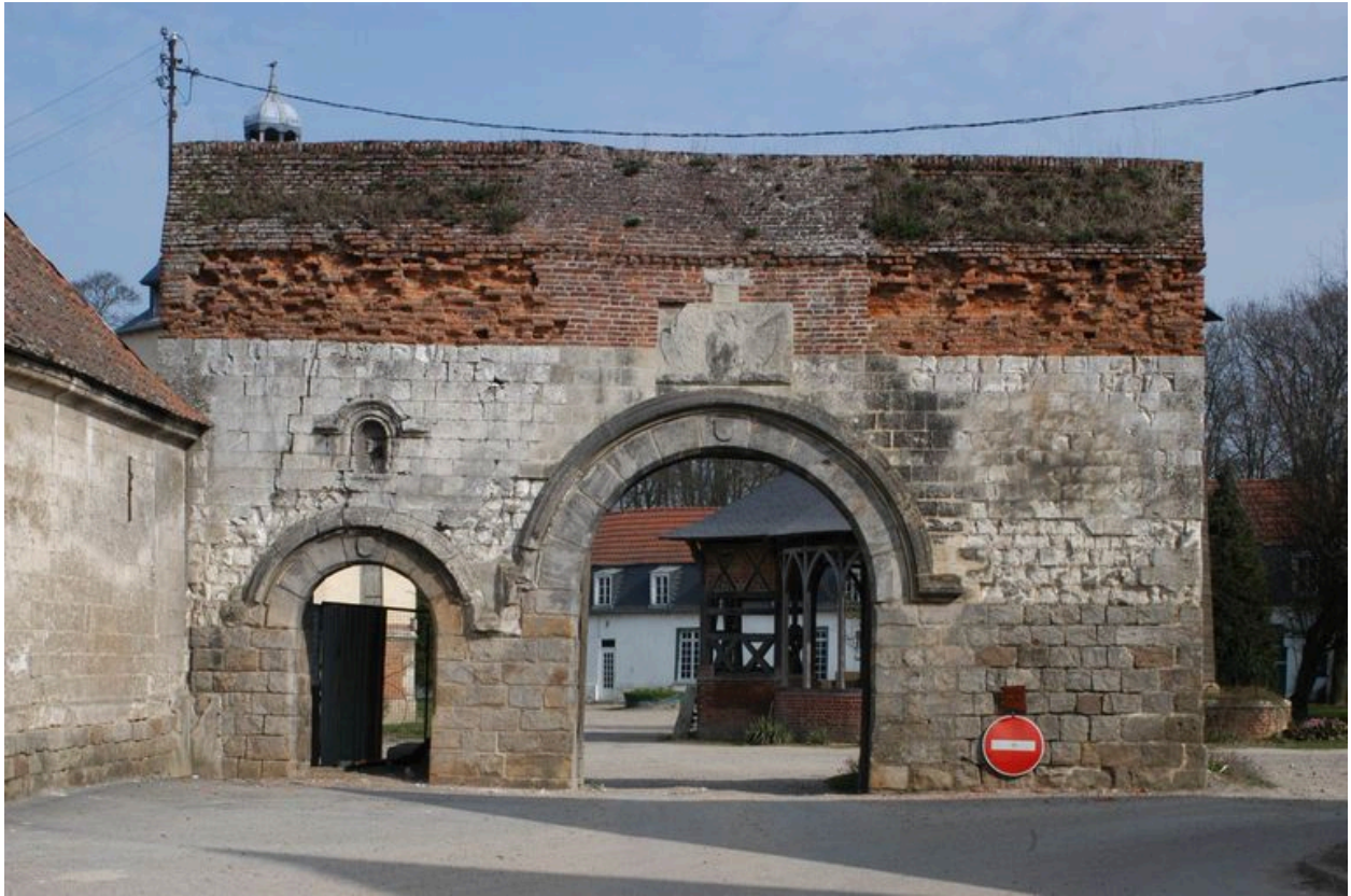
Le portail de l'ancien manoir, donnant accès à la ferme (date portée 1623).
