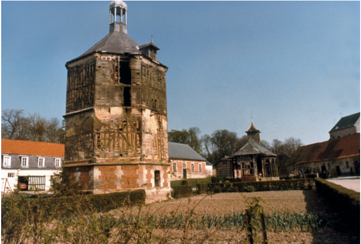
Le pigeonnier avant restauration, cliché réalisé en 1980 par Claude de Broissia (CRMH).
