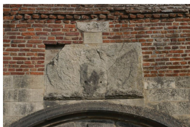
Détail sur le cartouche du portail. Phot. Thierry Lefébure IVR22_20038000257NUCA
