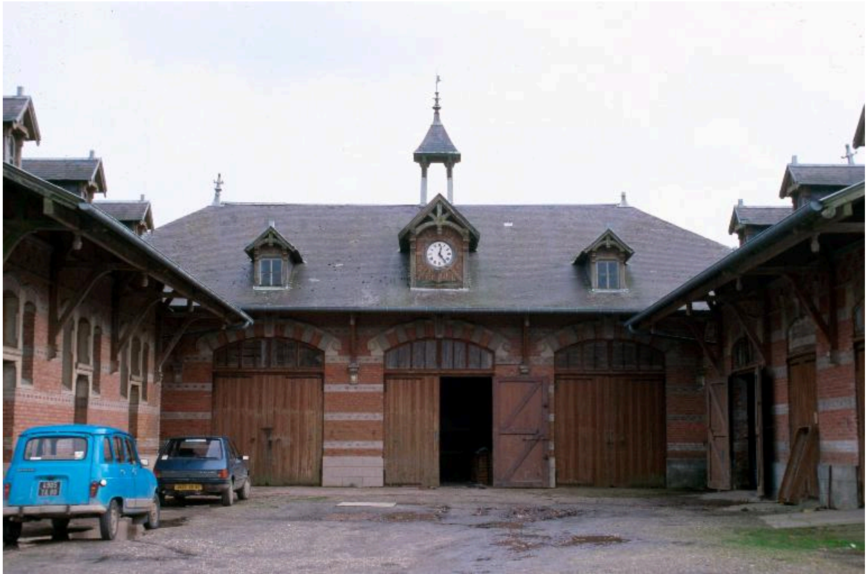
Remises, selleries et buanderie.
