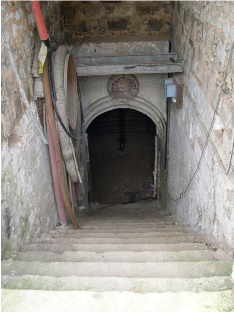
Détail sur l'accès aux caves.
