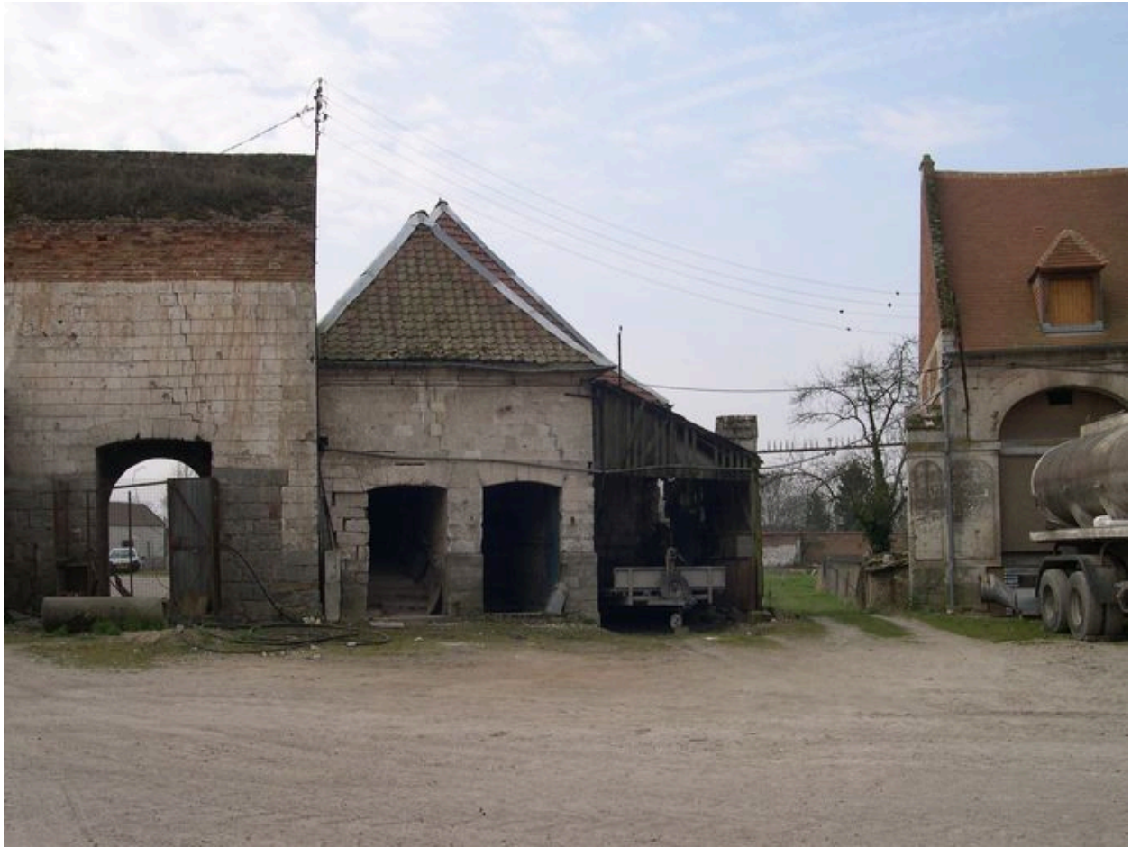
Grange et cellier, vue depuis le nord.
