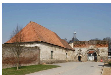
Grange et cellier, vue depuis le sud-est. Phot. Thierry Lefébure IVR22_20038000271NUCA
