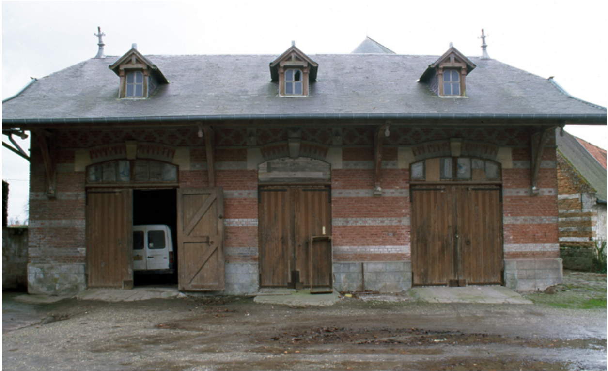
Remises et écuries.
