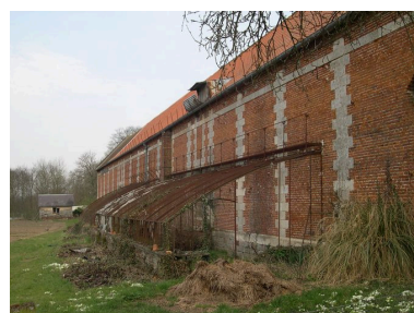
Granges, au sud de la cour, et serre accolée à la façade sud. Phot. Isabelle Barbedor IVR22_20038010160NUCA
