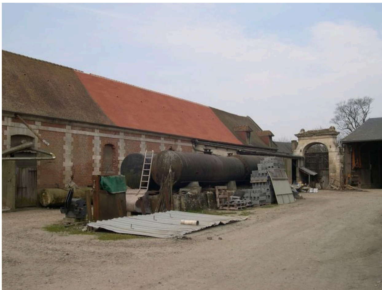
Granges, au sud de la cour, façade nord.
