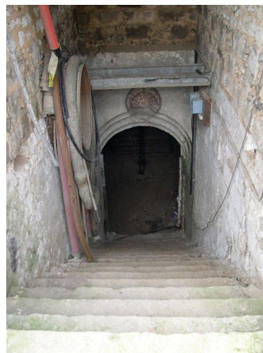
Détail sur l'accès aux caves. Phot. Isabelle Barbedor IVR22_20038010158NUCA
