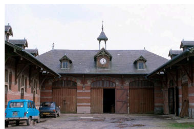
Remises, selleries et buanderie. Phot. Irwin Leullier IVR22_20008000164ZA
