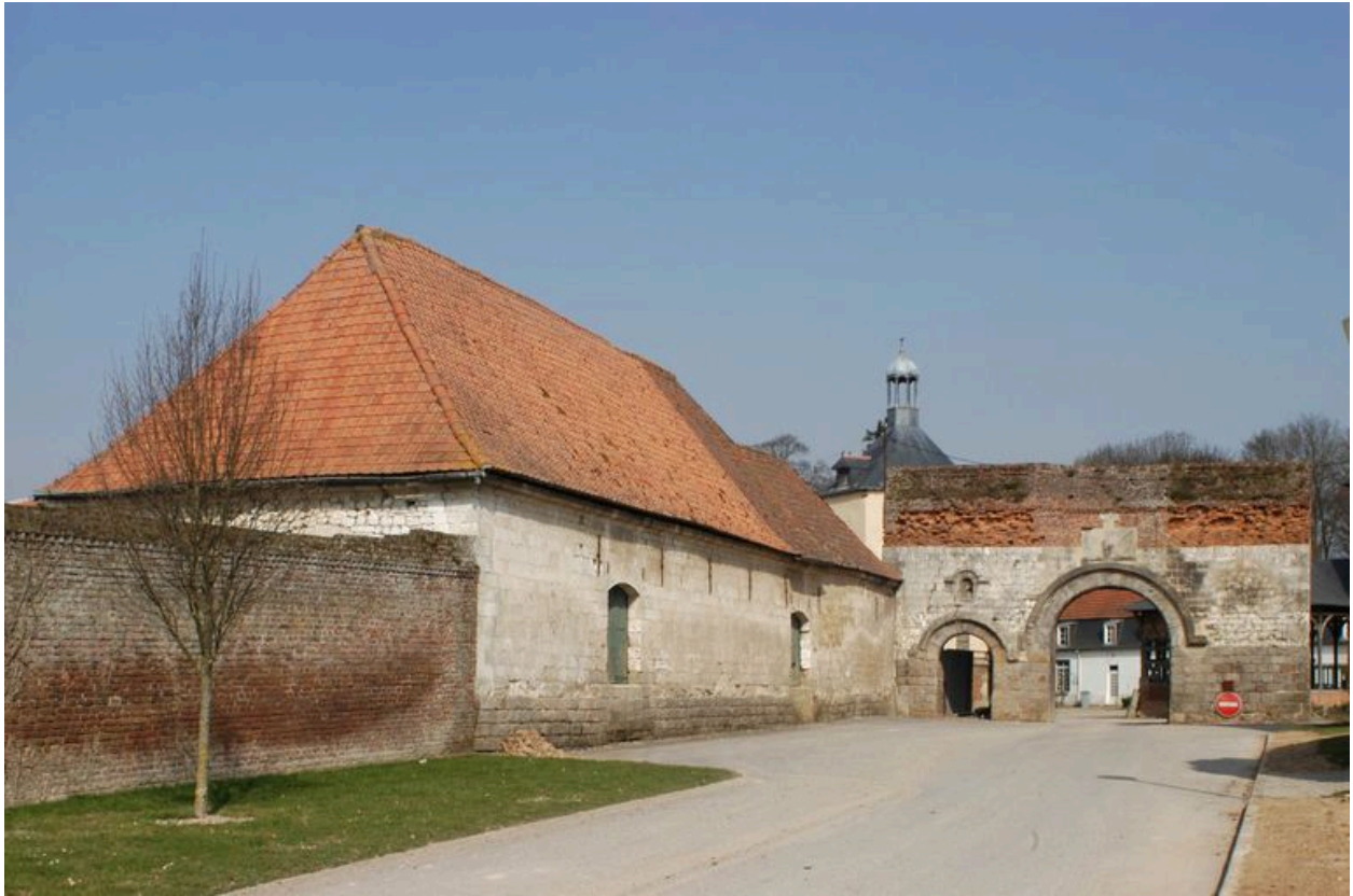
Grange et cellier, vue depuis le sud-est.
