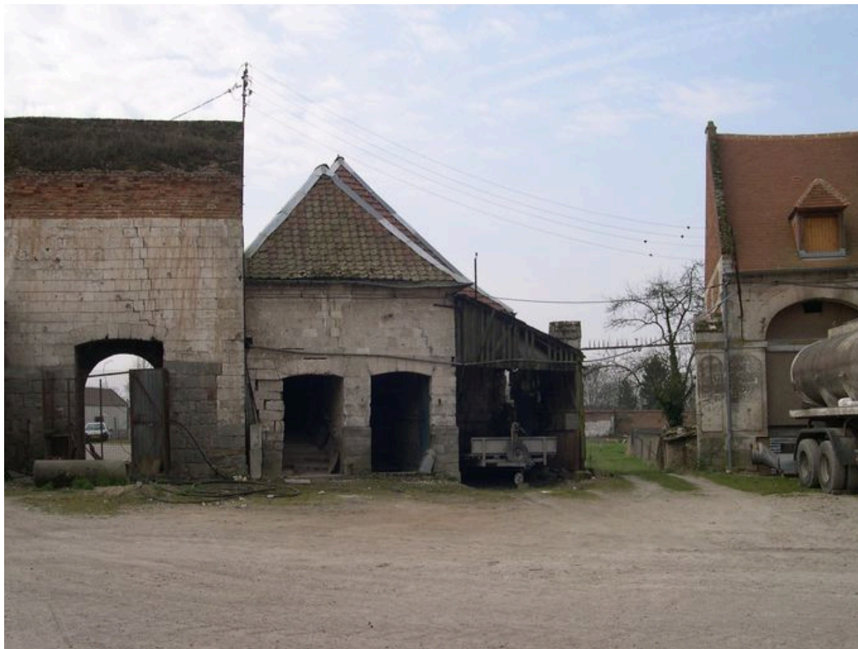
Grange et cellier, vue depuis le nord.
