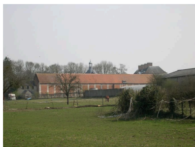
Vue de situation depuis la rue du Moulin. Phot. Isabelle Barbedor IVR22_20038010161NUCA
