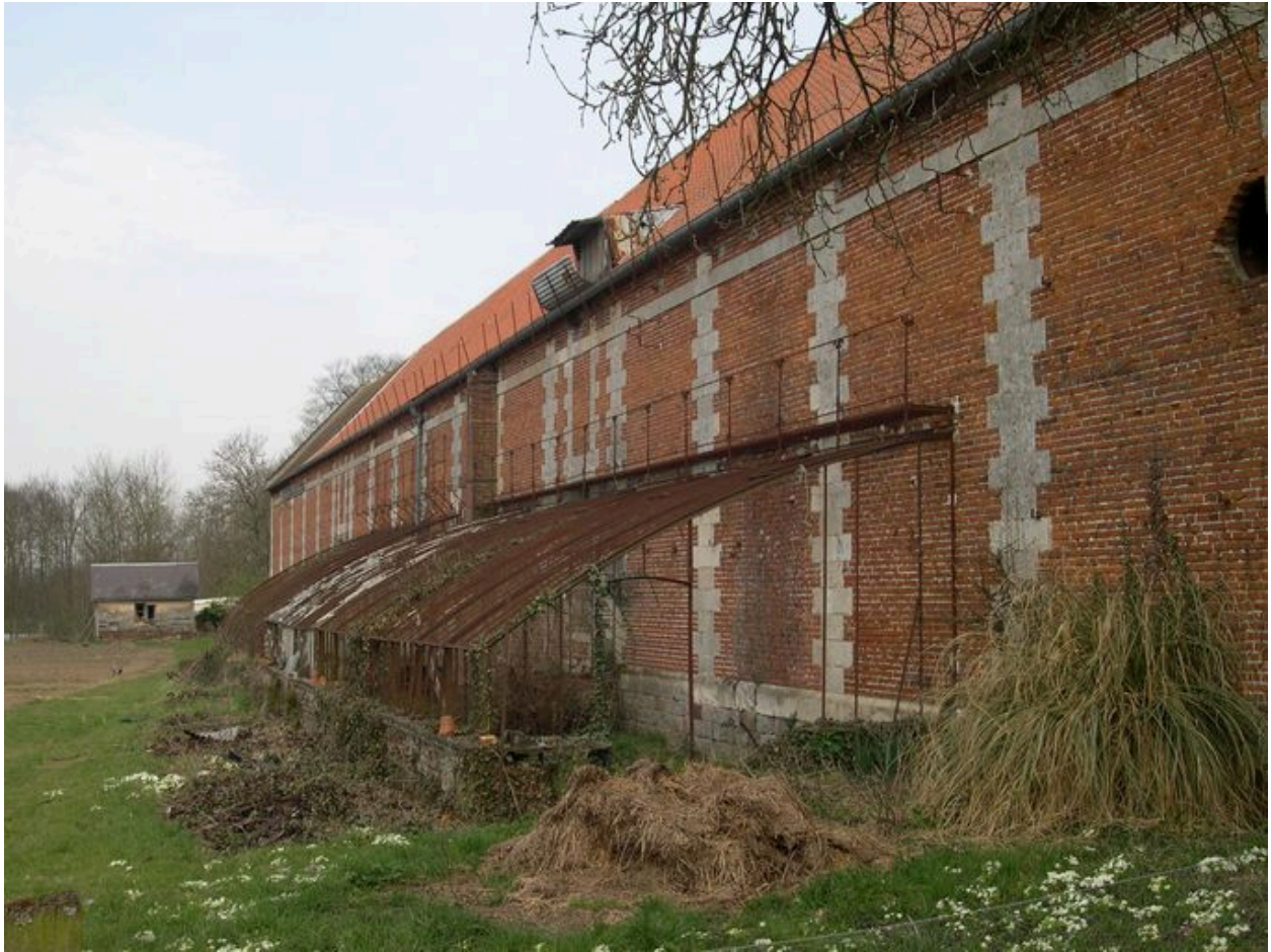
Granges, au sud de la cour, et serre accolée à la façade sud.
