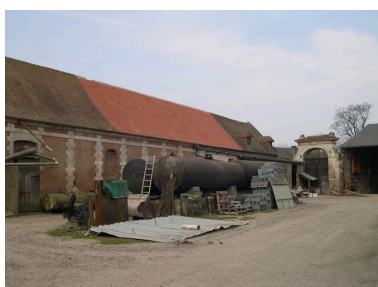
Granges, au sud de la cour, façade nord. Phot. Isabelle Barbedor IVR22_20038010159NUCA
