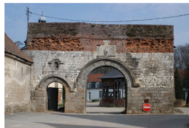
Le portail de l'ancien manoir, donnant accès à la ferme (date portée 1623). Phot. Thierry Lefébure IVR22_20038000258NUCA
