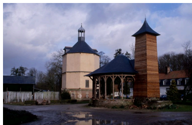
Le manège et le pigeonnier. Phot. Irwin Leullier IVR22_20008000107ZA
