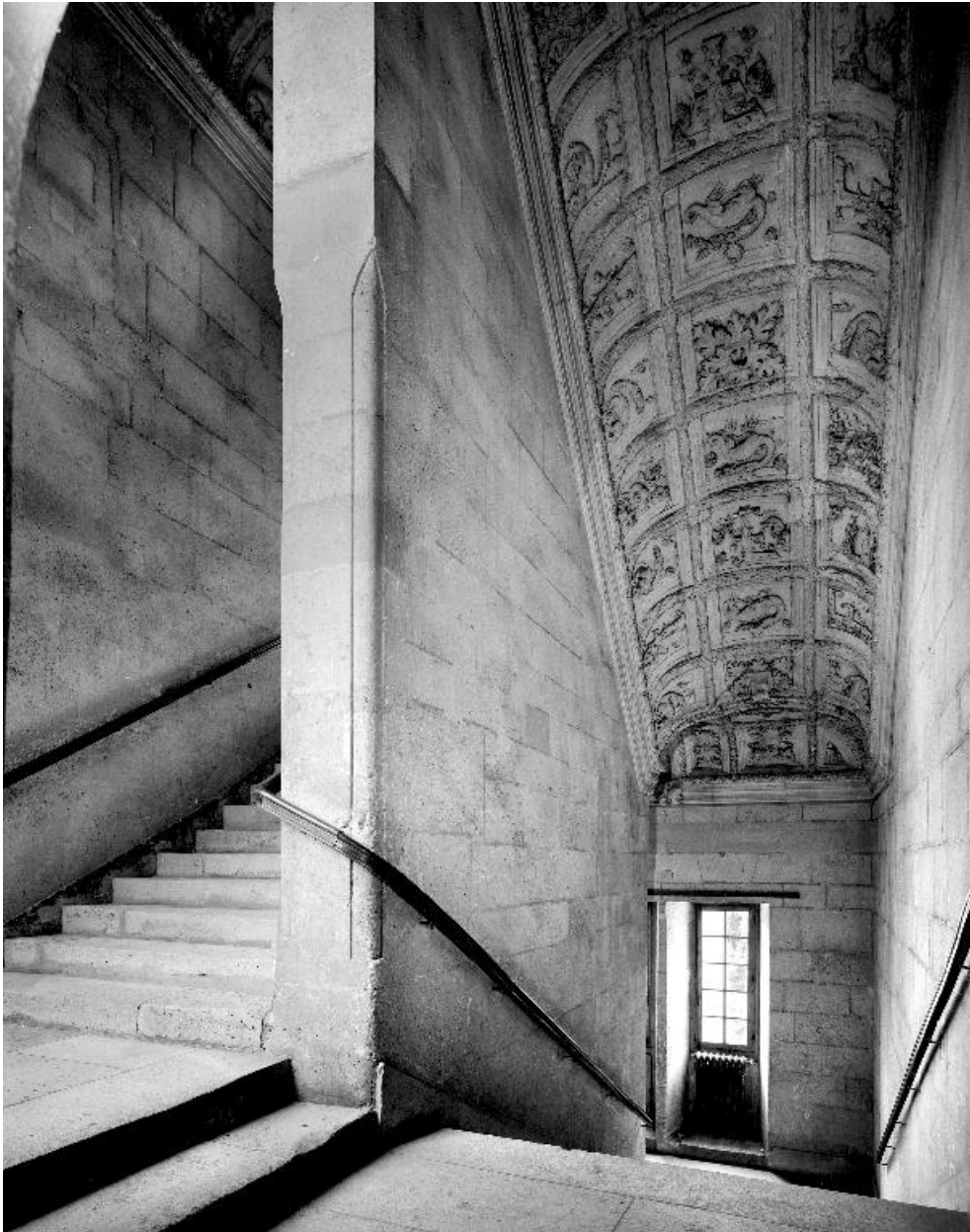
Vue de l'escalier depuis le palier du premier étage.
