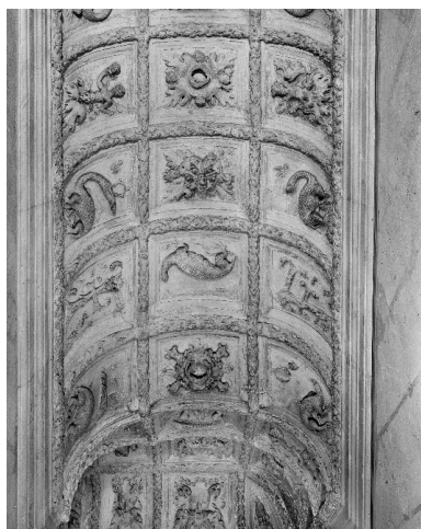
Vue partielle du décor de la voûte de la première volée. Phot. Thierry Lefébure IVR22_19910200437V
