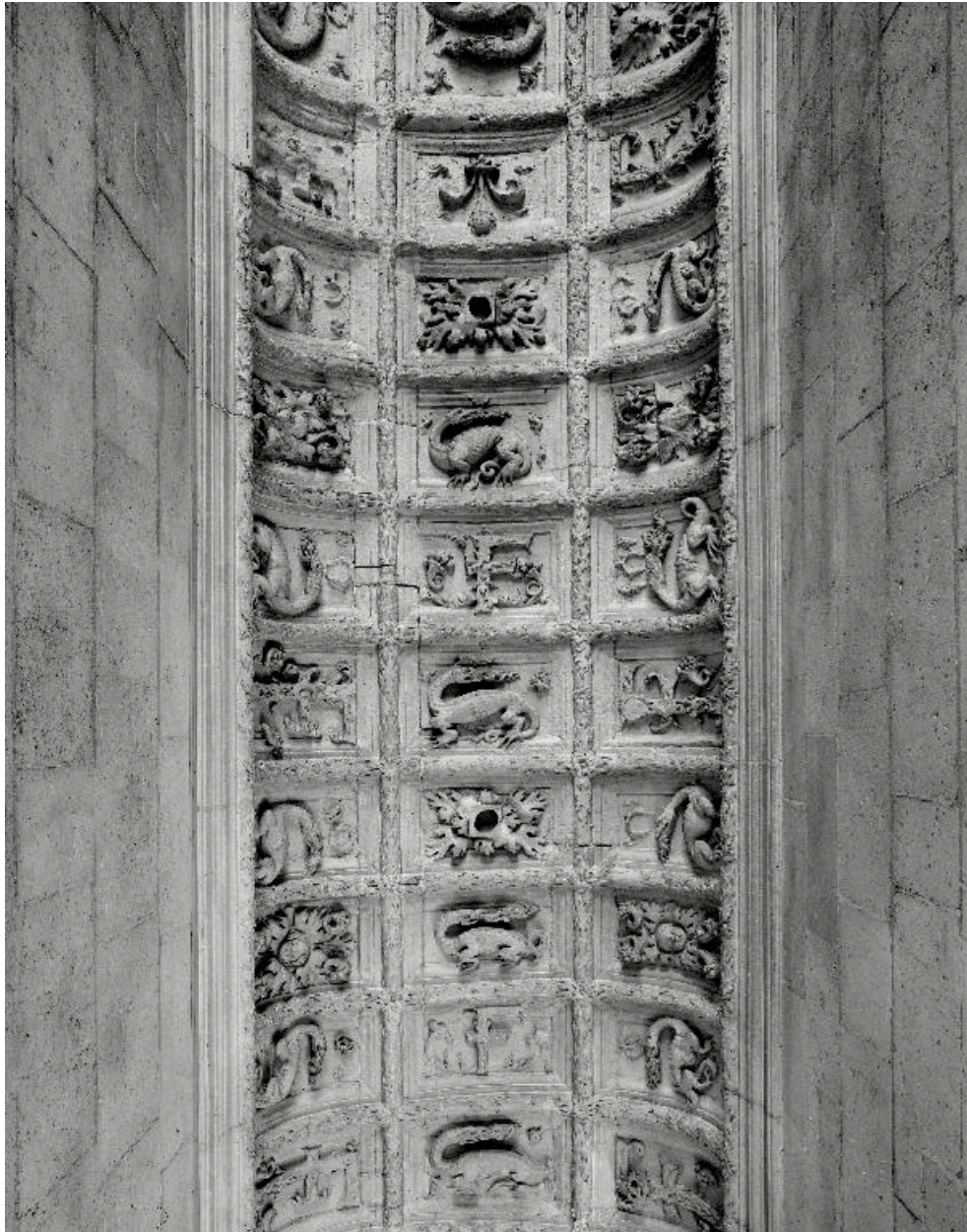
Vue de la voûte de la troisième volée.
