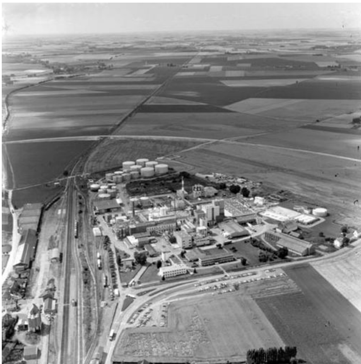
Vue aérienne, flanc est.
