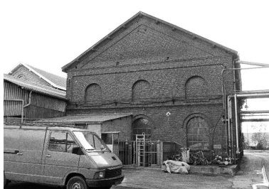
Atelier de fabrication, flanc nord.
