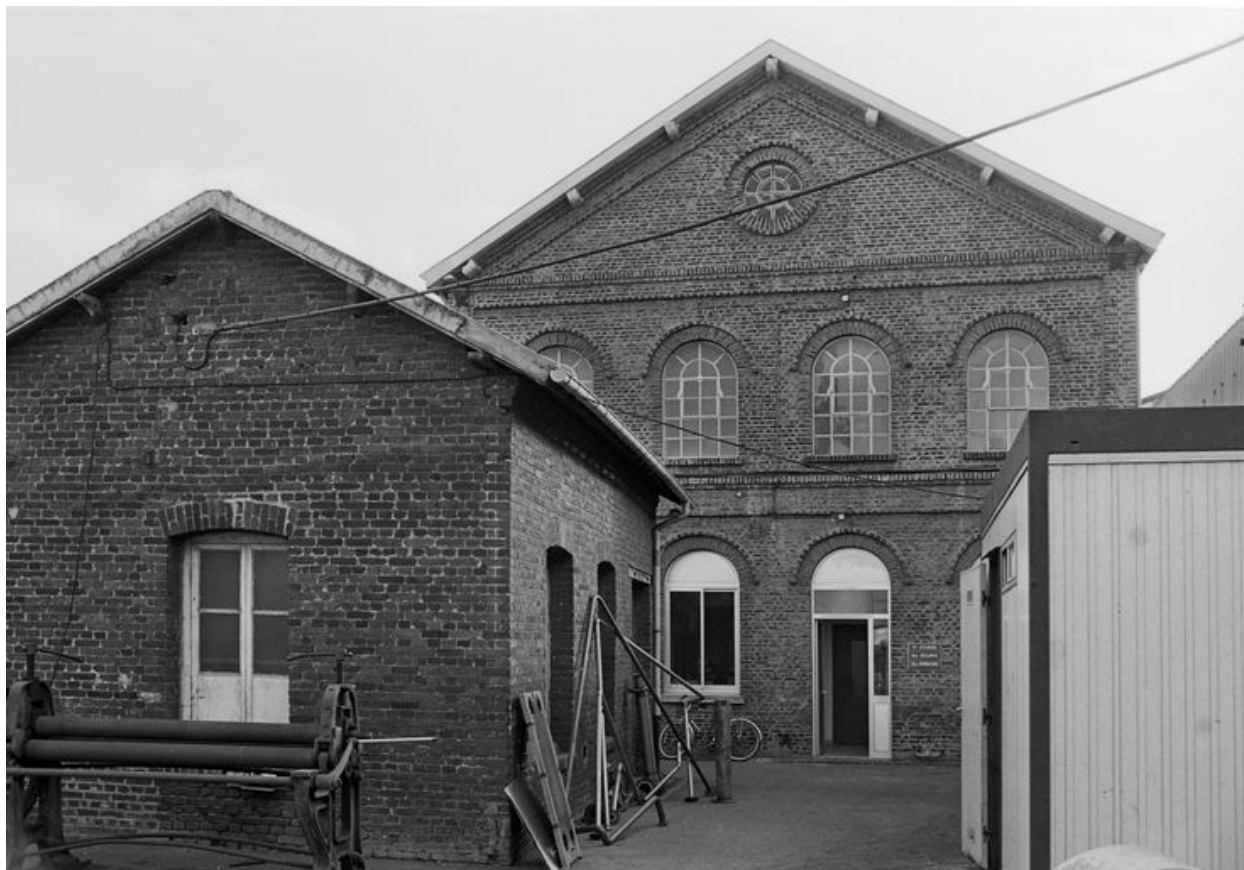
Atelier de fabrication, flanc nord.
