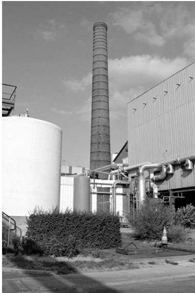
Cheminée d'usine. Phot. Francis Dubuc IVR22_19908001039Z
