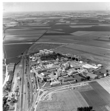
Vue aérienne, flanc est.
