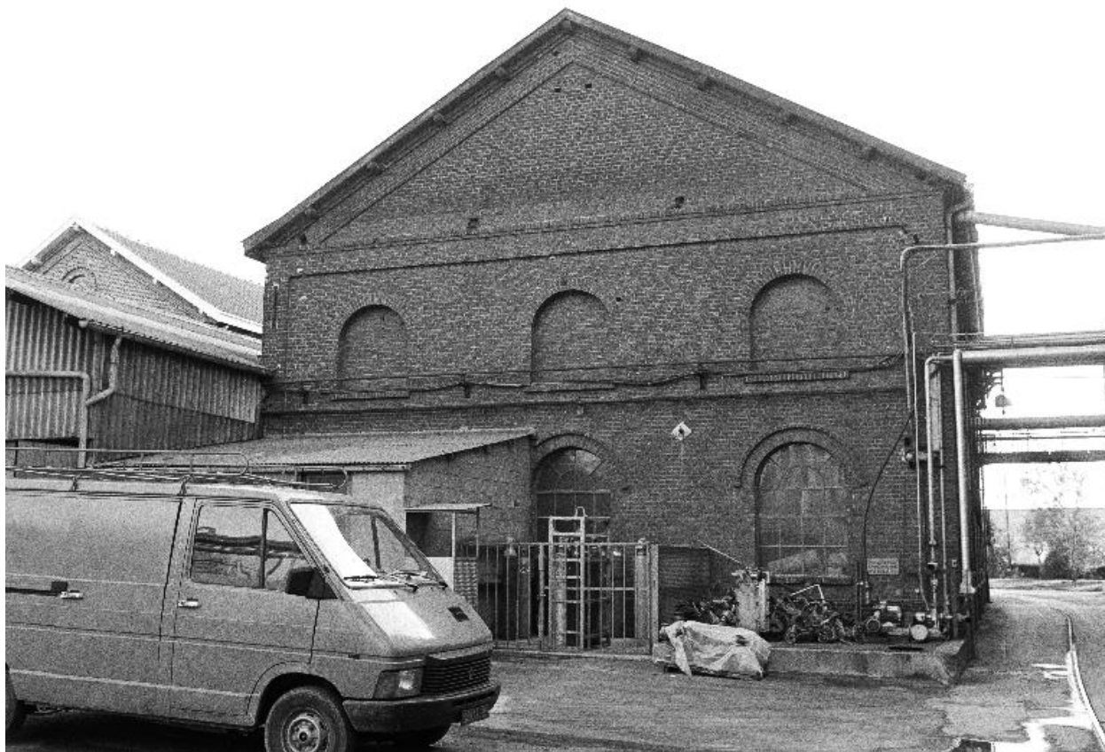
Atelier de fabrication, flanc nord.
