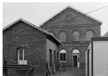
Atelier de fabrication, flanc nord.
