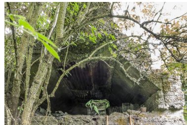
Combles, côté sud Phot. Jean-Marc Ramette IVR31_20145904426NUCA
