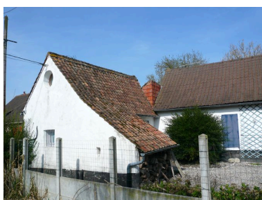
Vue du bâtiment à l'ouest. Phot. Inès Guérin IVR22_20078005775NUCA
