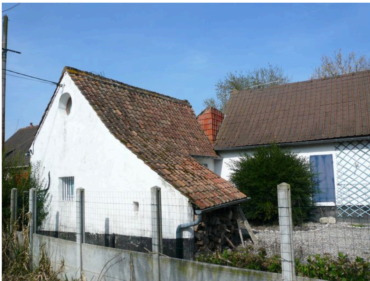
Vue du bâtiment à l'ouest.
