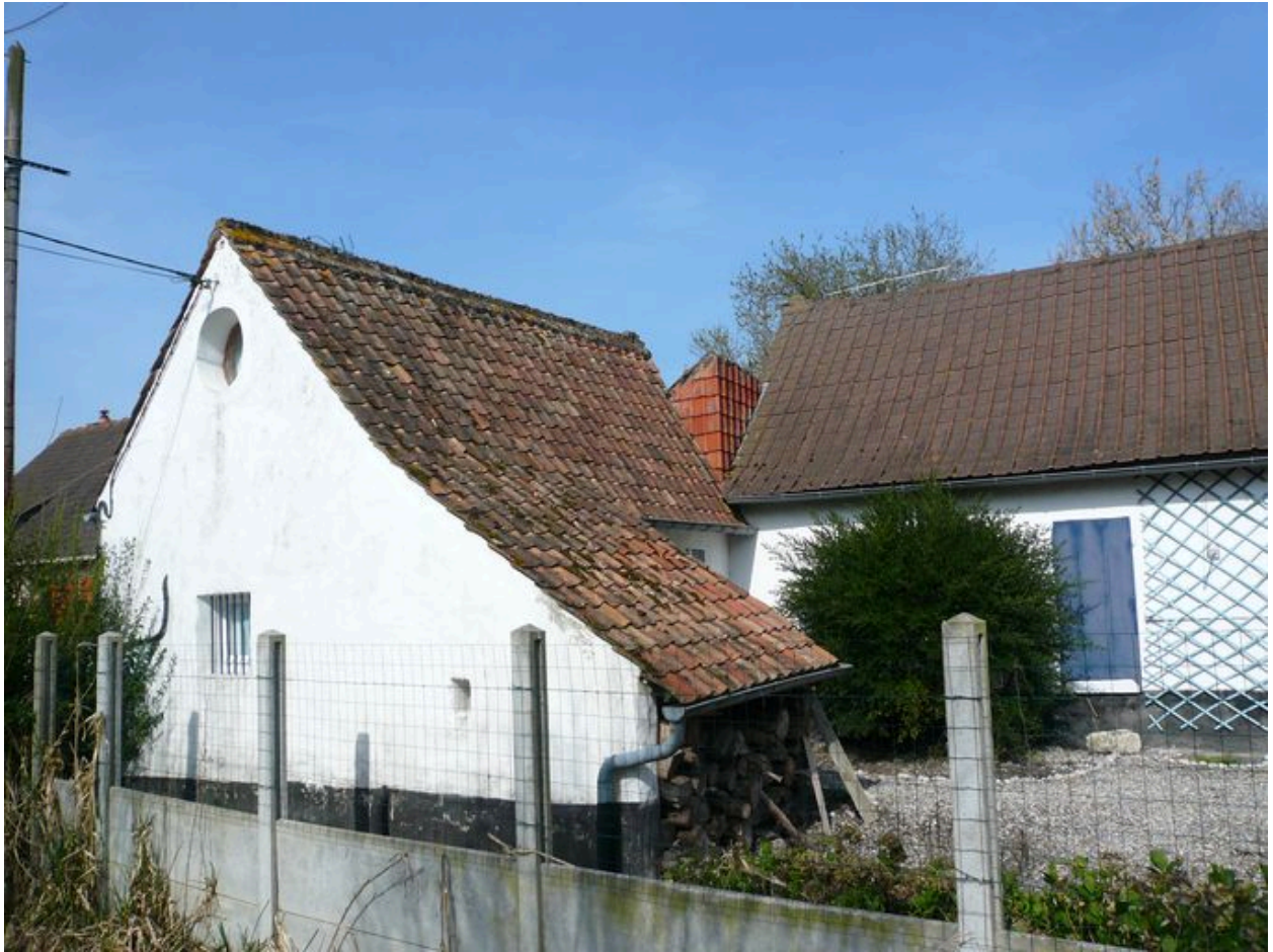
Vue du bâtiment à l'ouest.
