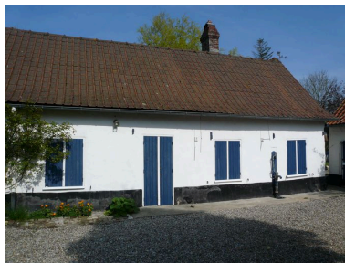
Vue du logis en fond de cour. Phot. Inès Guérin IVR22_20078005772NUCA
