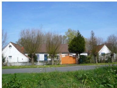
Vue générale. Phot. Inès Guérin IVR22_20078005771NUCA
