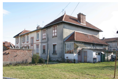
Bâtiment à huit logements. Phot. Frédéric Pillet IVR22_20060205224NUCA
