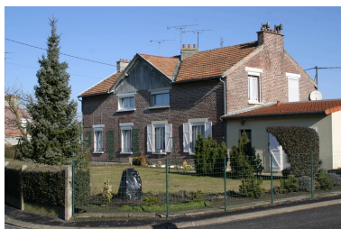
Bâtiment à quatre logements. Phot. Frédéric Pillet IVR22_20060205223NUCA
