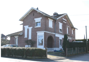
Logements associés à l'école. Phot. Frédéric Pillet IVR22_20060205228NUCA
