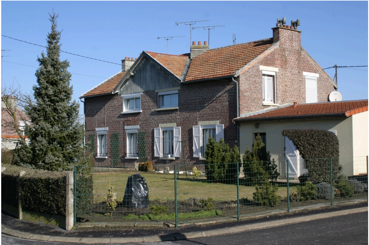
Bâtiment à quatre logements.
