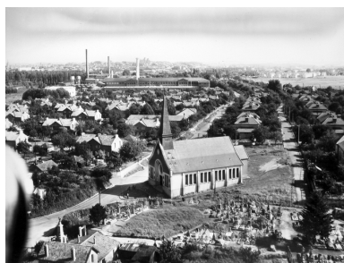
Vue aérienne, vers 1960 (AD Aisne). Phot. Pillet Frédéric IVR22_20050206560NUCAB
