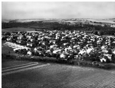
Vue générale de la cité ouvrière, vers 1960 (AD Aisne). Phot. Pillet Frédéric IVR22_20050206558NUCAB
