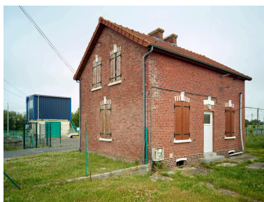
La maison de service (aval).
