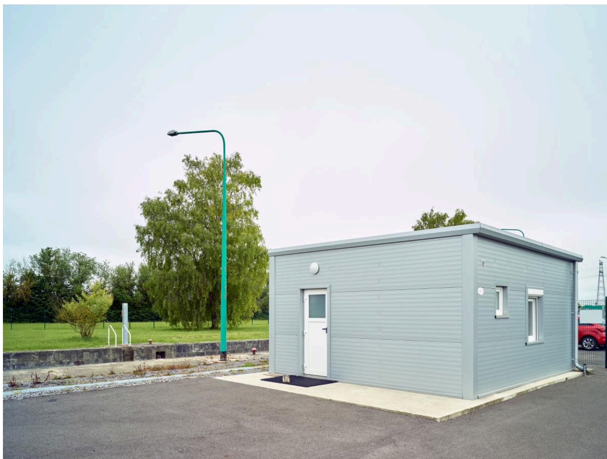
Le nouveau poste de commande.
