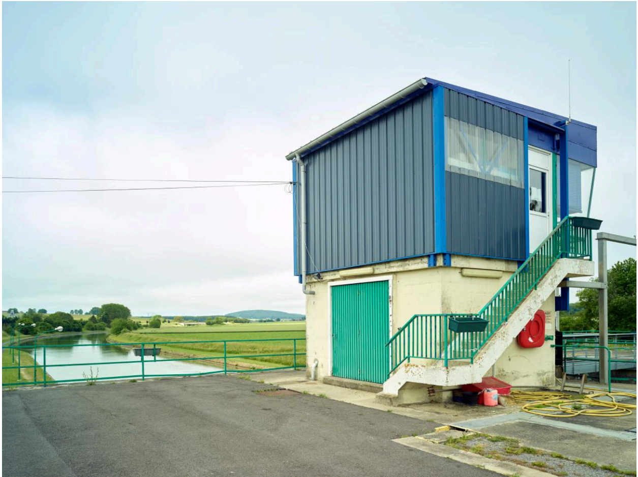
L'ancien poste de commande en aval du site.
