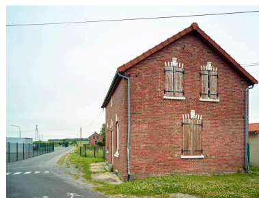
La maison de service (aval).
