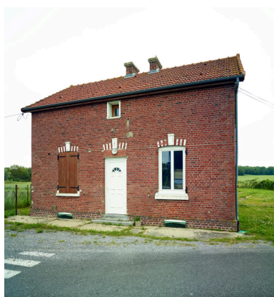
La maison de service (amont).
