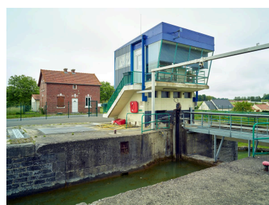
L'ancien poste de commande. Au second plan, la maison de service (aval). Phot. Pierre Thibaut IVR32_20216000817NUCA
