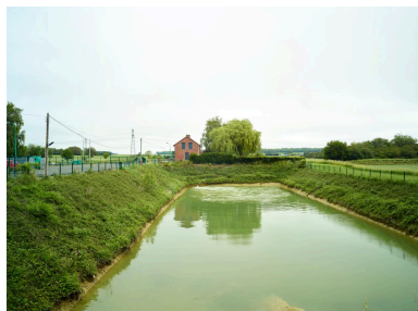
Le bassin d'épargne. Au second plan la maison de service (amont).
