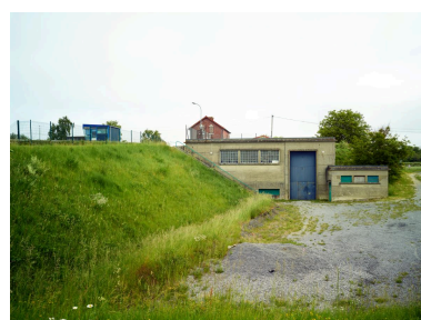
La station de pompage. Phot. Pierre Thibaut
