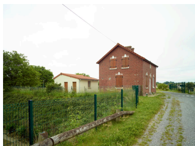
La maison de service (aval).
