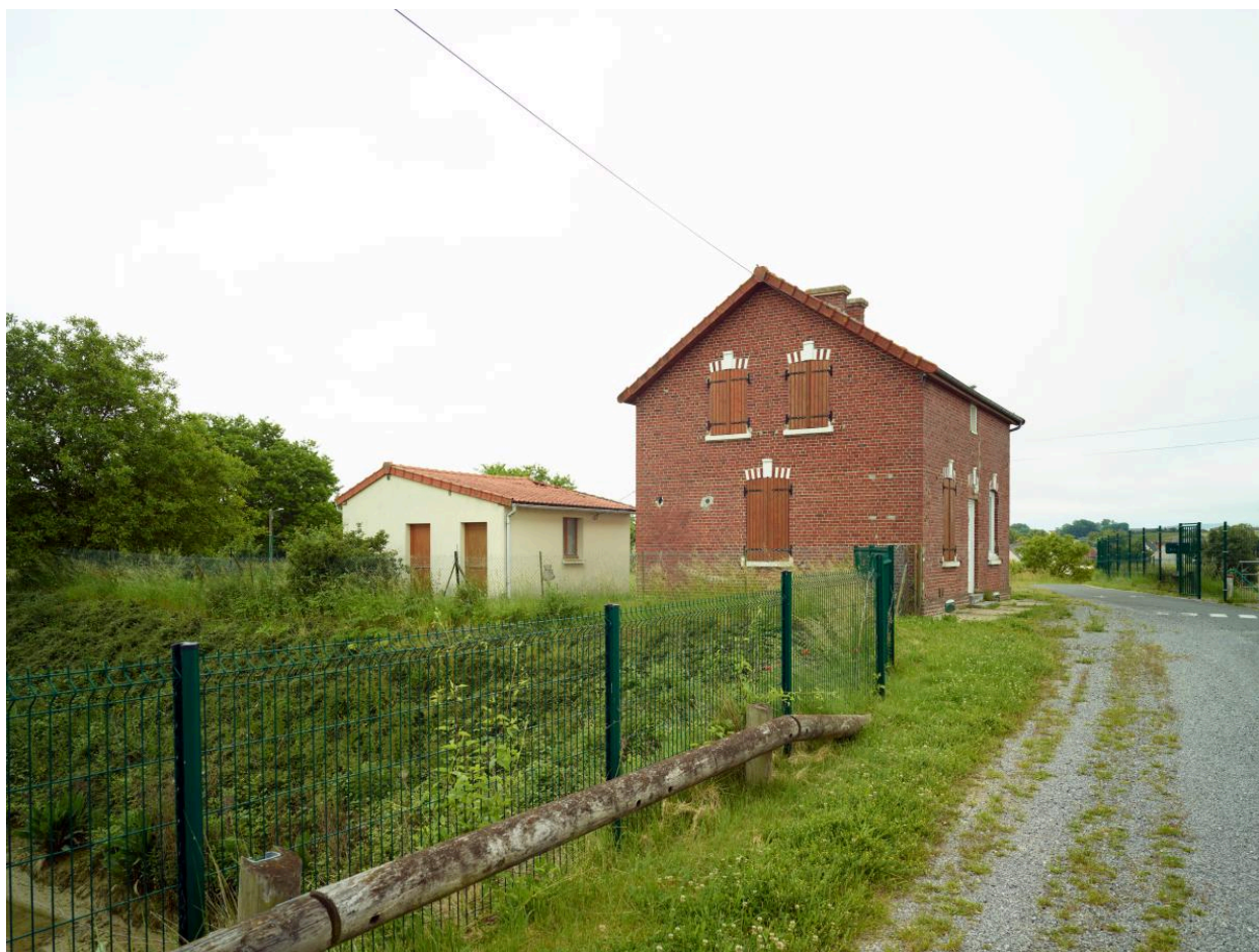
La maison de service (aval).
