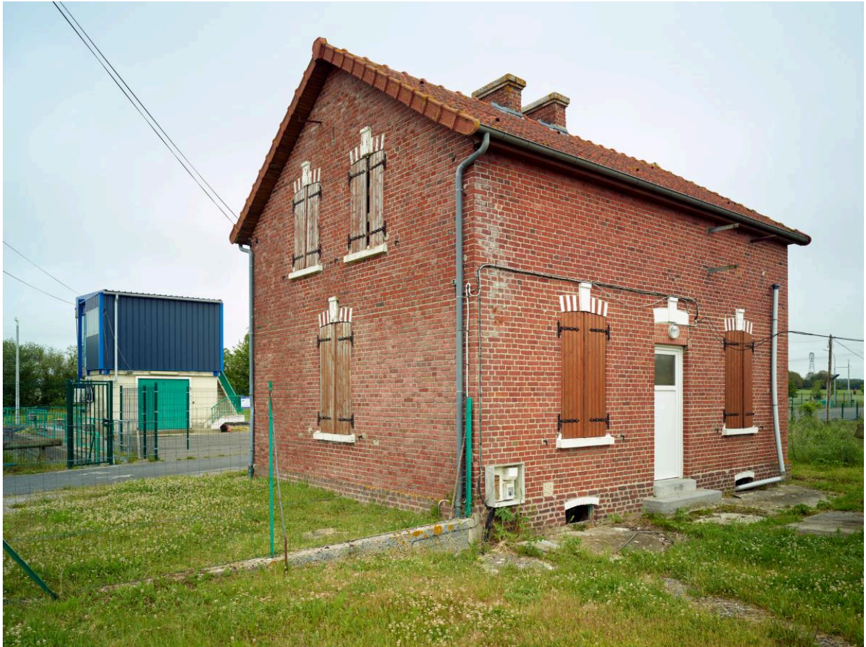
La maison de service (aval).
