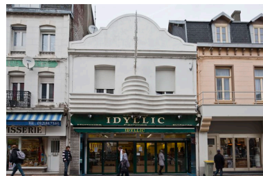
Ancien cinéma rue de l'Impératrice. Phot. Hubert Bouvet IVR31_20116201011NUCA
