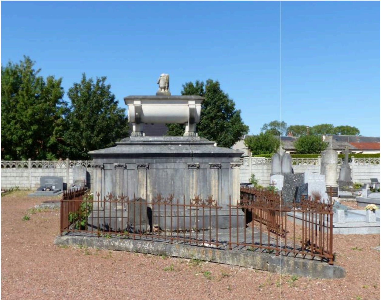
Vue générale, depuis l'est.
