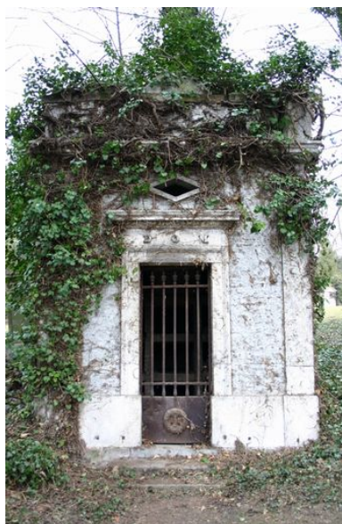
Tombeau (chapelle), Lefèvre fils (entrepreneur), vers 1843. Phot. Caroline Vincent IVR22_20098000824NUCA
