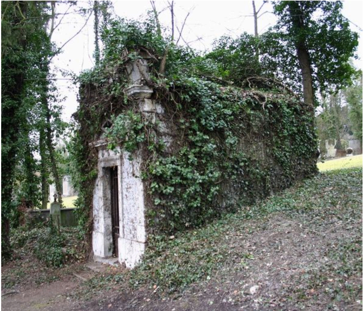
Vue générale, depuis le côté droit.
