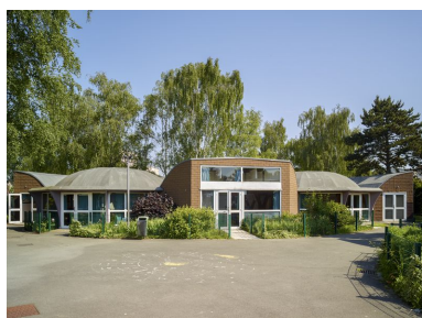
Le bâtiment de la cantine depuis la cour. Phot. Pierre Thibaut IVR32_20185900019NUCA
