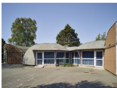
Dômes correspondant à deux classes de l'école primaire, partie sud-est. Phot. Pierre Thibaut IVR32_20185900020NUCA
