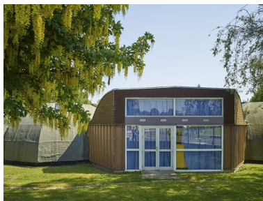
L'extrémité de l'école primaire depuis la rue de la Chesnaie.
