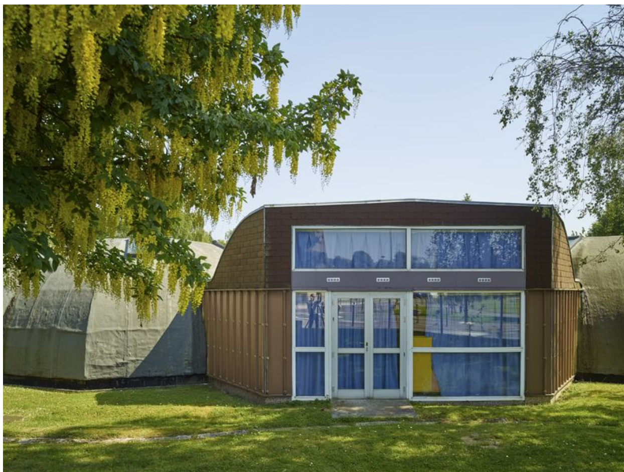
L'extrémité de l'école primaire depuis la rue de la Chesnaie.
