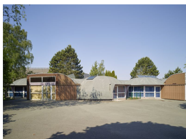
Partie sud de l'école élémentaire. Phot. Pierre Thibaut IVR32_20185900023NUCA
