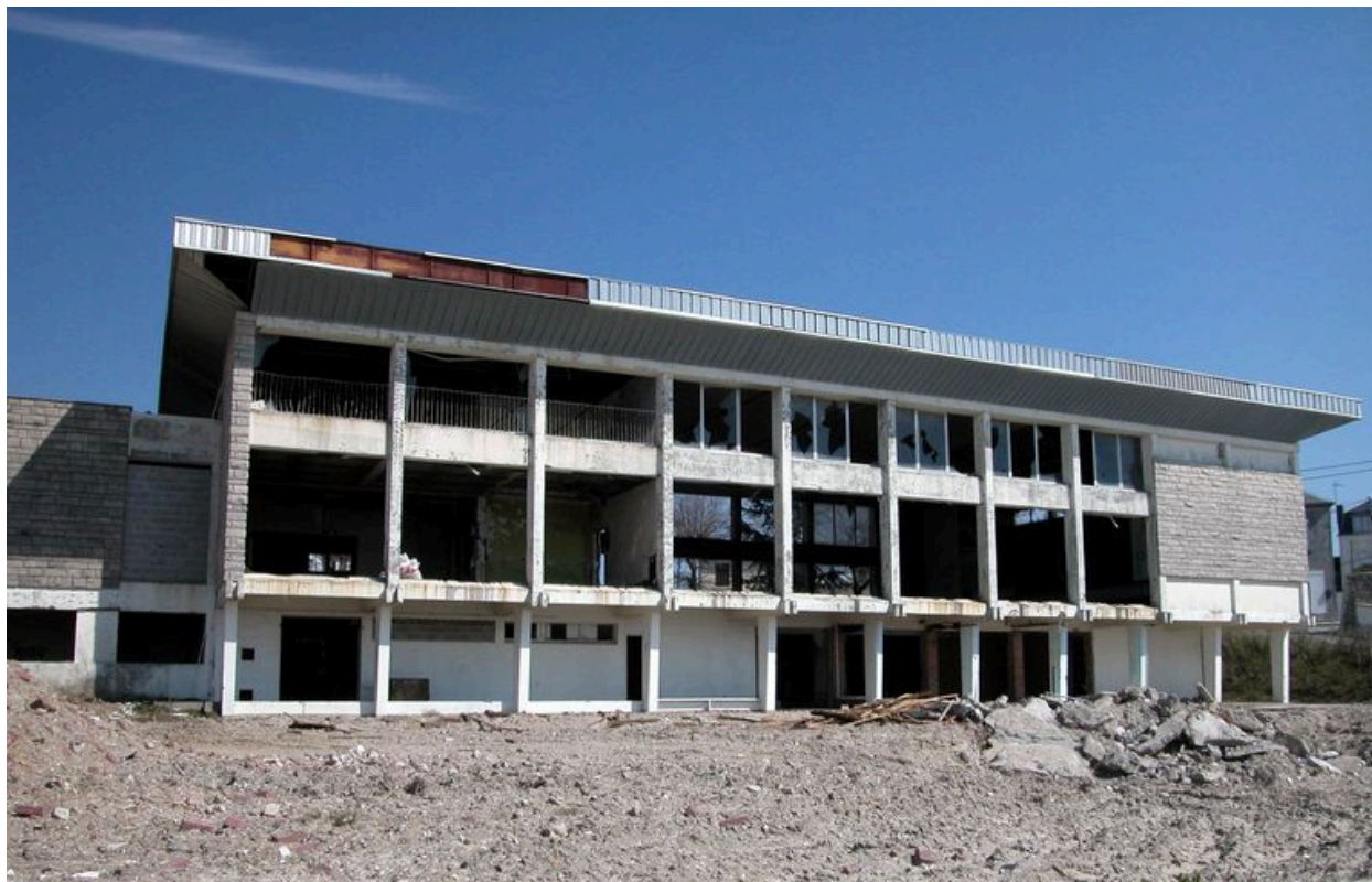
Le casino de 1966 en cours de démolition, mars 2005.
