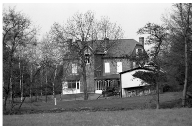
Elévation de la maison, à côté du moulin (détruit). Phot. Christiane Riboulleau IVR22_19960200432Z
