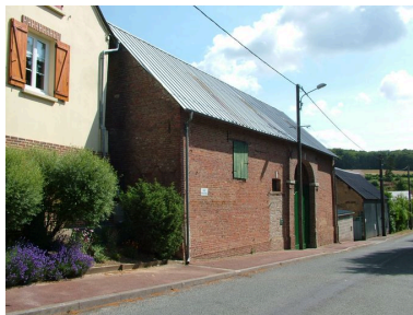
Vue générale depuis la rue, en amont. Phot. Frédéric Fournis IVR22_20108001756NUCA
