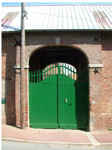
Porte charretière. Phot. Frédéric Fournis IVR22_20108001754NUCA
