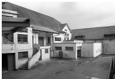
Élévation sur cour des bâtiments de la beurrerie. Phot. Thierry Lefébure IVR22_19960200166X
