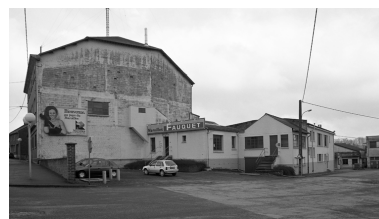
Entrée de l'usine, magasins de vente et bureaux administratifs. Phot. Thierry Lefébure IVR22_19960200156X
