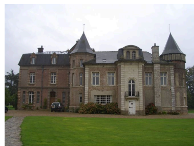
Vue générale depuis le nord. Phot. Inès Guérin IVR22_20068005593NUCA
