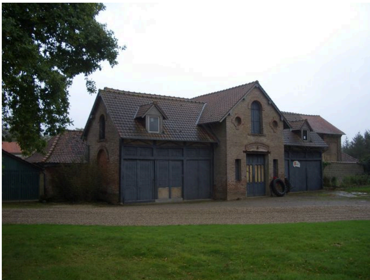
Vue des dépendances du château.
