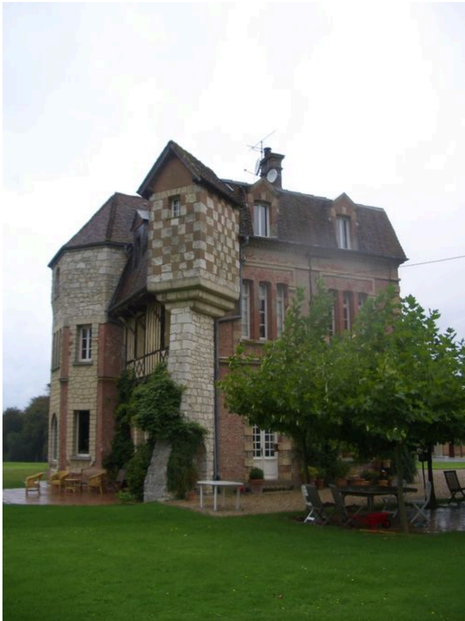
Vue latérale de la façade orientale.
