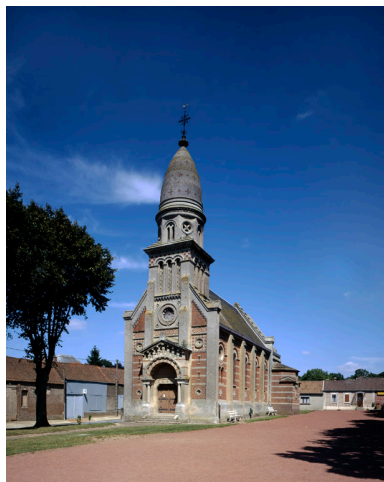
Vue générale, de trois-quarts. Phot. Irwin Leullier IVR22_19988000813VA
