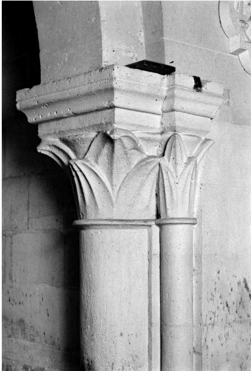
Chapiteaux des colonnes qui supportent un des arcs sud de la nef (près de la sacristie).
