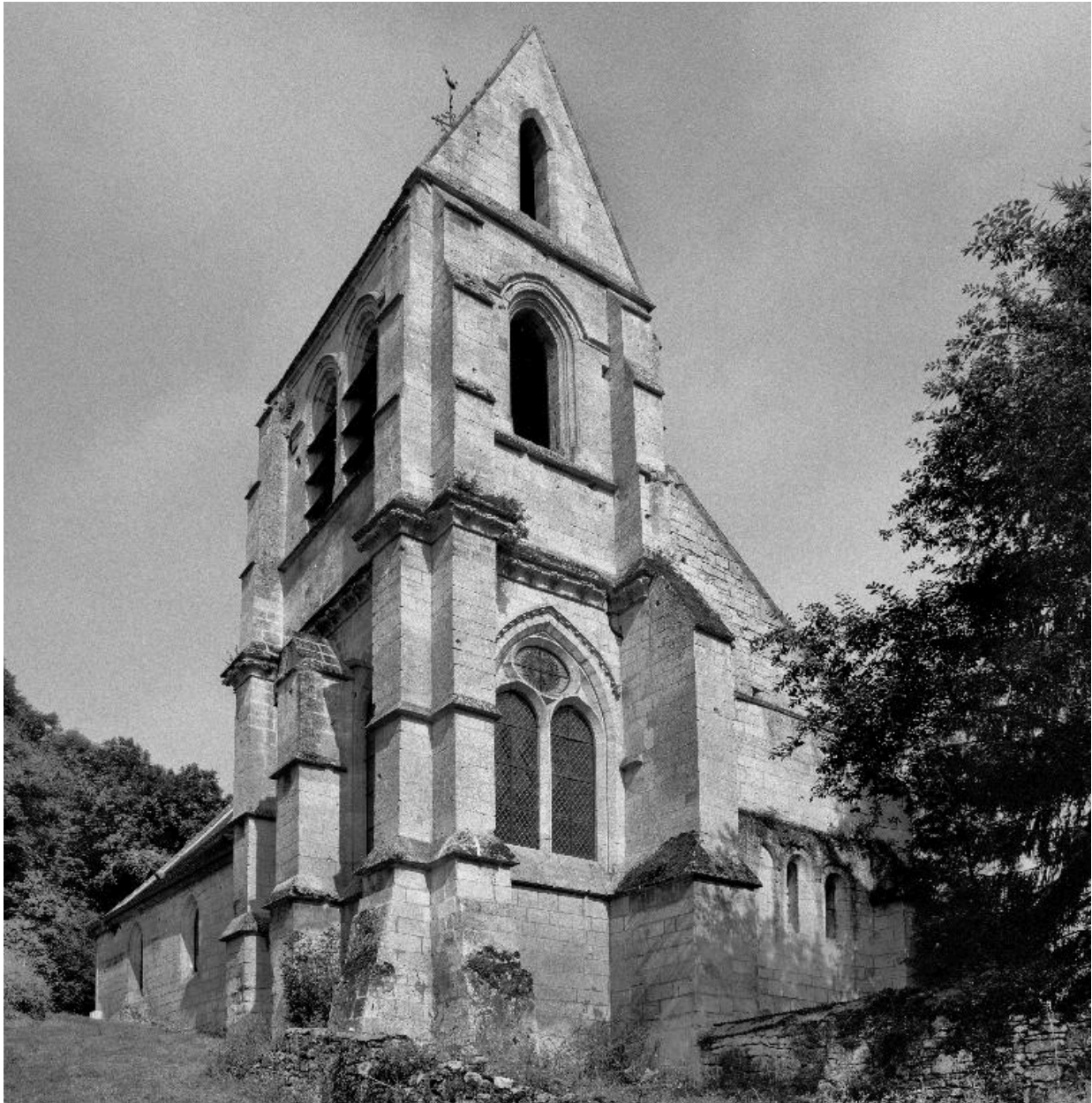
Vue du clocher et du chevet de l'église, depuis le sud-est.
