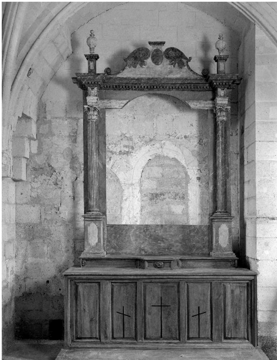
Vue du mur oriental du chœur, où se remarque l'emplacement d'un triplet muré.
