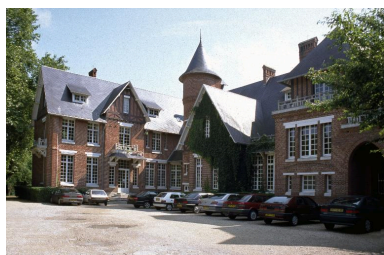
Détail de la maison du directeur. Phot. Bertrand Fournier IVR22_20008000418ZA
