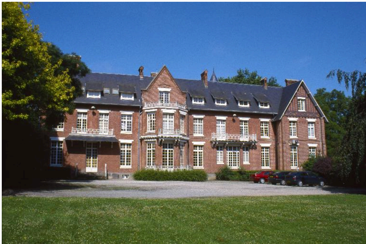
Vue d'ensemble de la façade principale.
