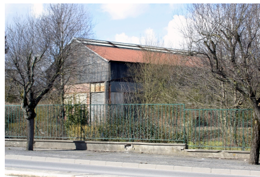
Les ateliers vus depuis la route de Chauny. Phot. Frédéric Pillet IVR22_20060205142NUCA
