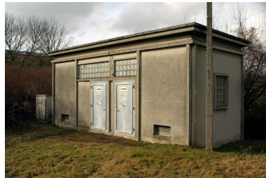
Le transformateur. Phot. Frédéric Pillet IVR22_20060205186NUCA
