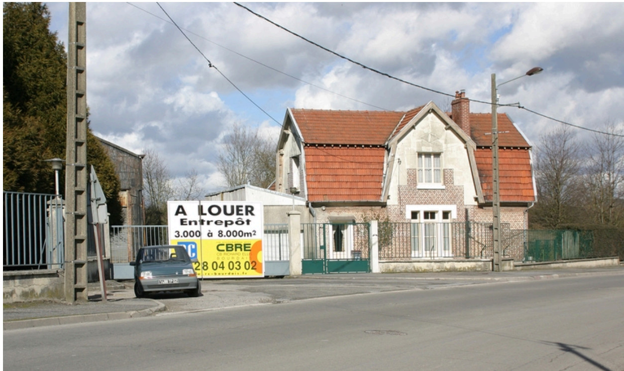
Entrée du site, route de Chauny.
