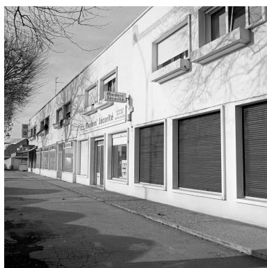
Vue générale de l'alignement de boutiques avenue de la gare. Phot. Thierry Petitberghien IVR31_20025902918X
