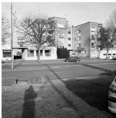
Vue générale du deuxième immeuble en forme de H. Phot. Thierry Petitberghien IVR31_20025902913X
