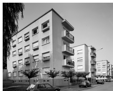
Vue générale de l'alignement des immeubles, élévations nord, rue des Arts. Phot. Thierry Petitberghien IVR31_19945901646V
