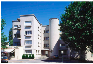
Élévation sud avenue de la gare, de l'immeuble en forme de H. Phot. Thierry Petitberghien IVR31_19945901136ZA
