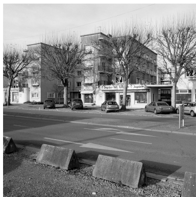
Vue générale du deuxième immeuble en forme de H. Phot. Thierry Petitberghien IVR31_20025902914X
