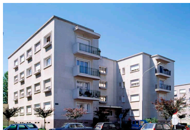
Vue générale d'un immeuble en forme de H, rue des Arts. Phot. Thierry Petitberghien IVR31_19945901159ZA
