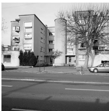
Vue générale de l'élévation sud d'un immeuble en H, avenue de la gare. Phot. Thierry Petitberghien IVR31_20025902912X
