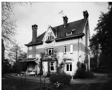
Vue générale de l'élévation latérale.
