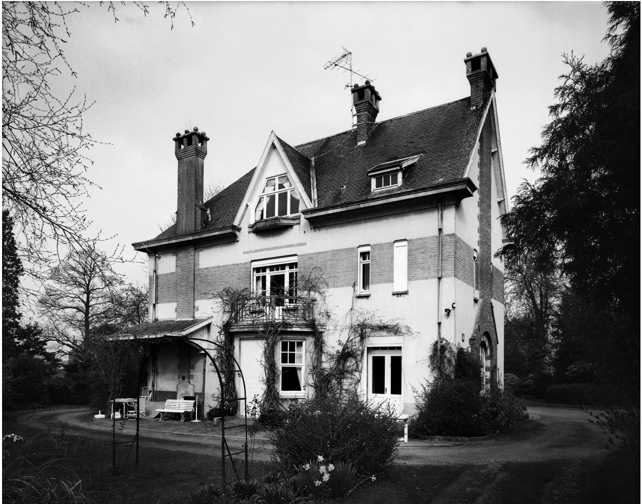
Vue générale de l'élévation latérale.
