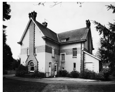
Vue générale des élévations postérieures. Phot. Thierry Petitberghien IVR31_20025901004V
