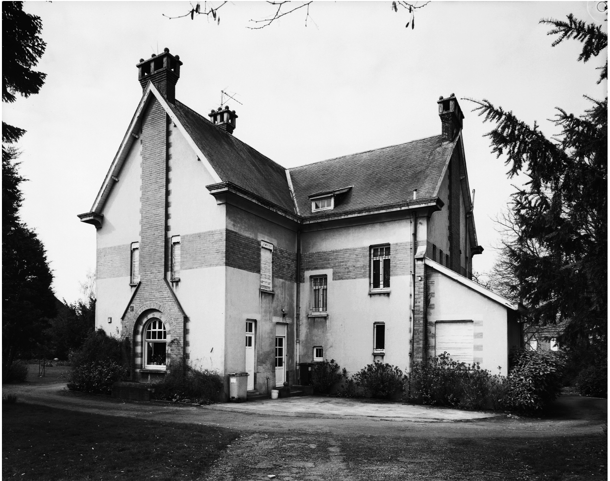
Vue générale des élévations postérieures.
