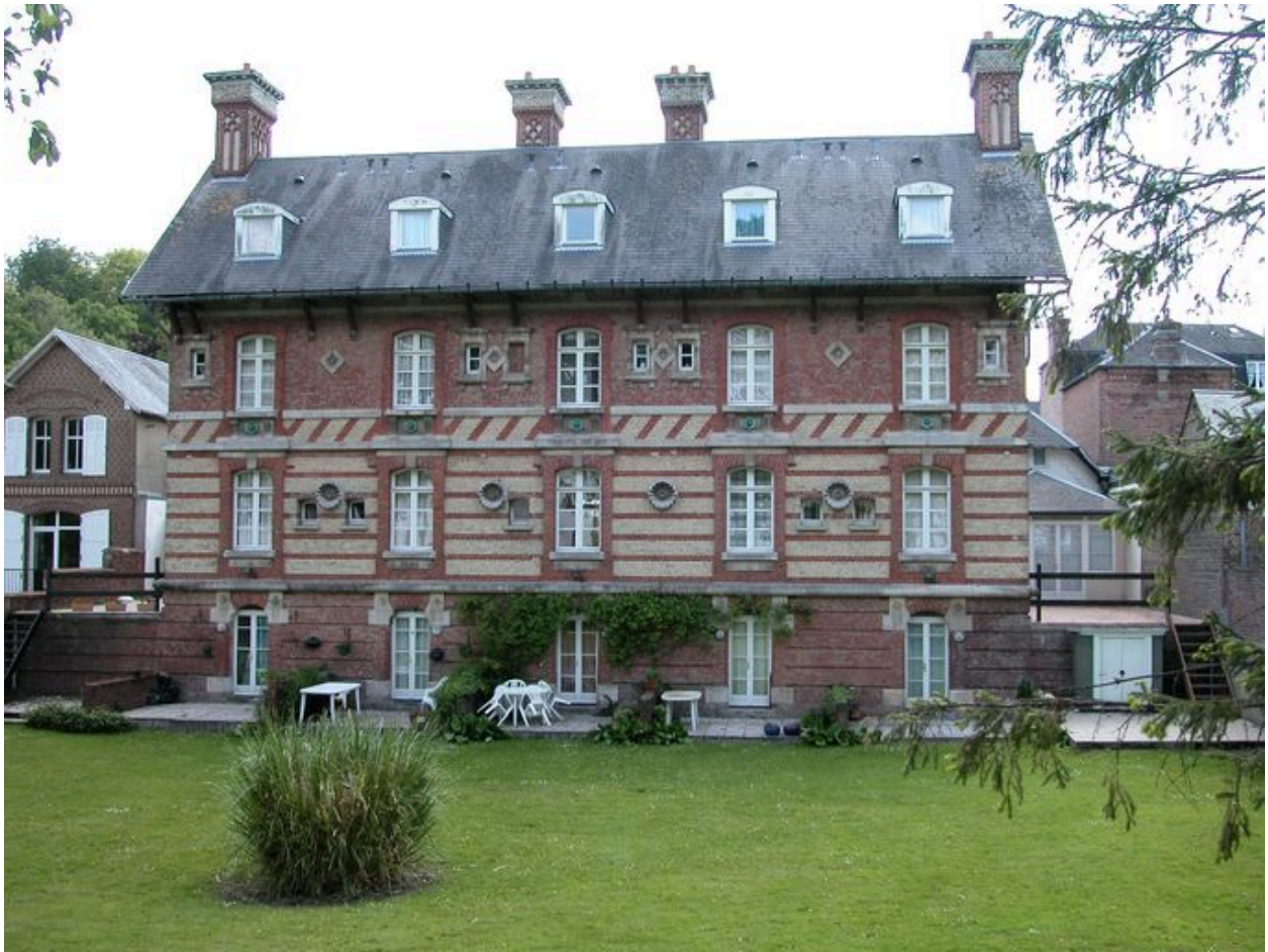
Elévation postérieure, côté digue.
