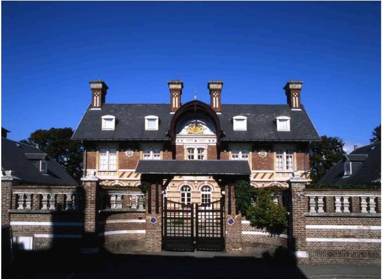
Vue d'ensemble depuis la rue.
