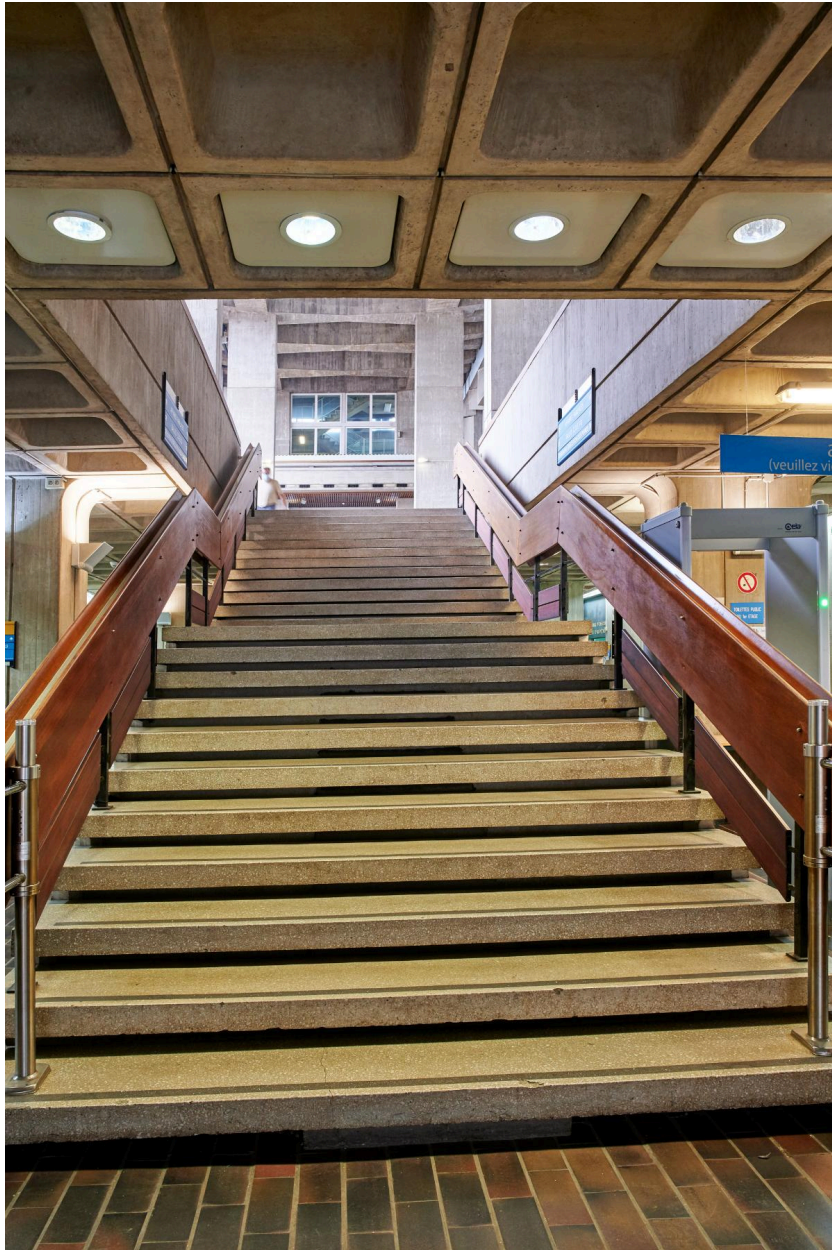
Escalier monumental du hall d'accueil (rez-de-chaussée bas) menant à la salle des pas-perdus.
