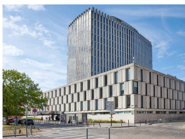
Vue du palais de justice depuis l'angle de l'avenue du Peuple-Belge et de la rue Alphonse-Colas. Phot. Pierre Thibaut IVR32_20225900605NUCA
