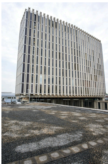
Façade sud de la tour, vue prise depuis le toit-terrasse du bâtiment bas.
