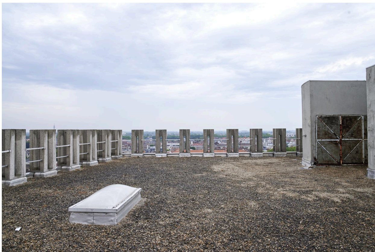
Acrotères en « schokbeton » cernant le toit-terrasse de la tour.
