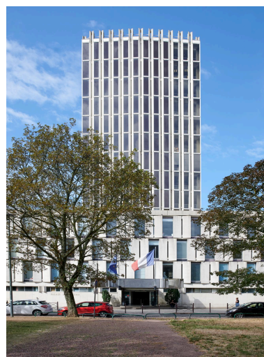
Élévation donnant sur l'avenue du Peuple-Belge. Phot. Pierre Thibaut
