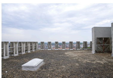
Acrotères en « schokbeton » cernant le toit-terrasse de la tour.
