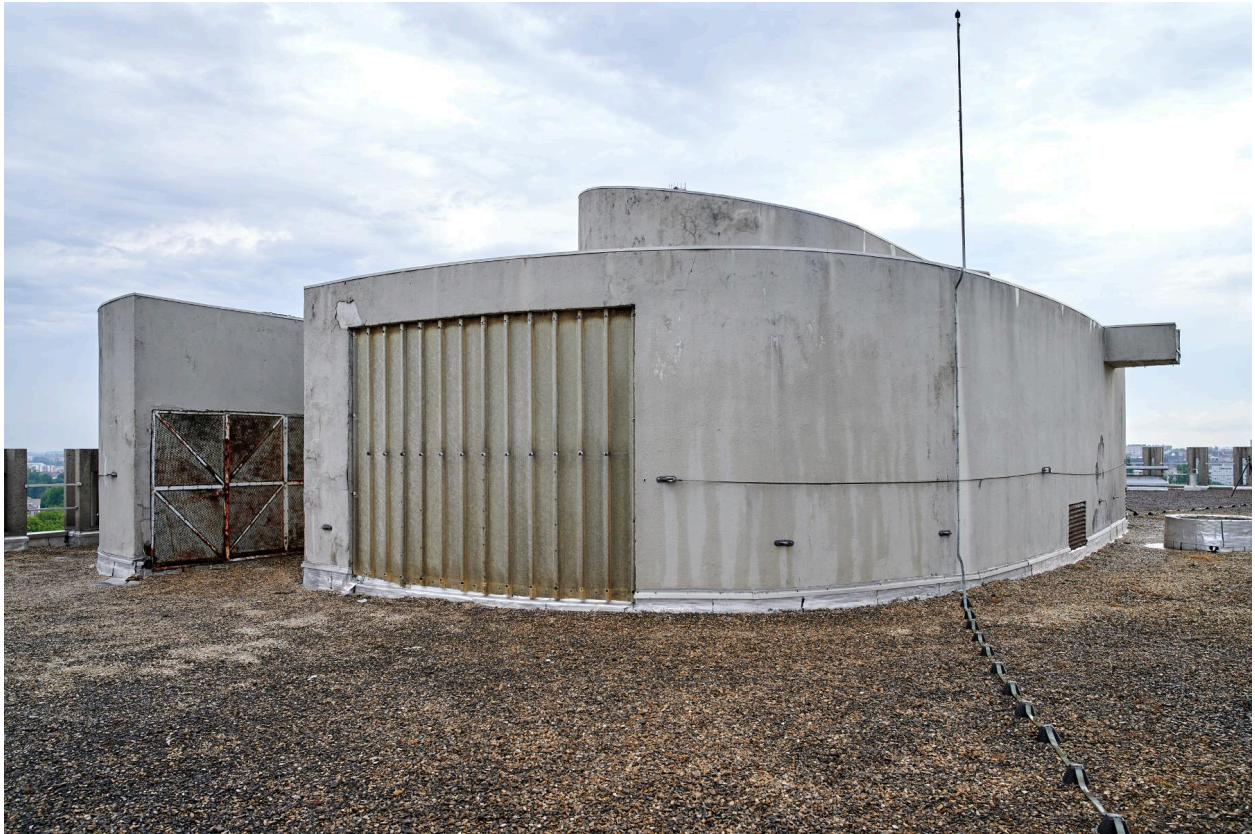
Toit-terrasse de la tour et local technique.
