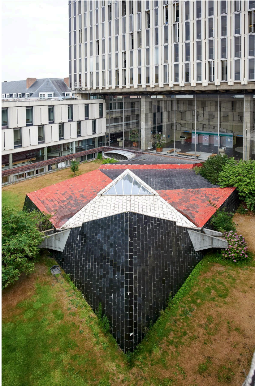
Le patio ouvert d'un lanterneau éclairant l'ancienne grande salle d'audience du tribunal d'instance.
