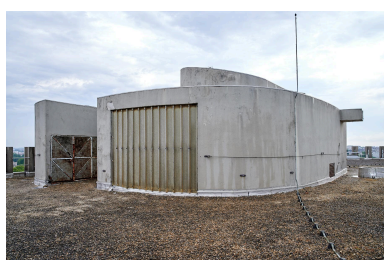
Toit-terrasse de la tour et local technique.
