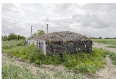
Vue de trois-quarts vers le sud-est Phot. Jean-Marc Ramette IVR32_20165901178NUCA
