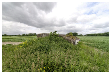
Vue générale vers le nord-est Phot. Jean-Marc Ramette IVR32_20165901179NUCA
