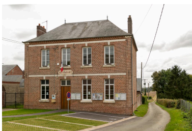
Vue de la mairie depuis le nord, 1867 (date portée sur la façade). Phot. Marc Kérignard IVR32_20216001115NUCA
