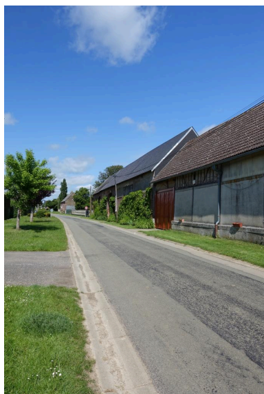
Vue générale depuis l'est de la rue du Pressoir avec l'usoir à gauche, vers le n°9. Phot. Lucile Chamignon IVR32_20216005092NUCA
