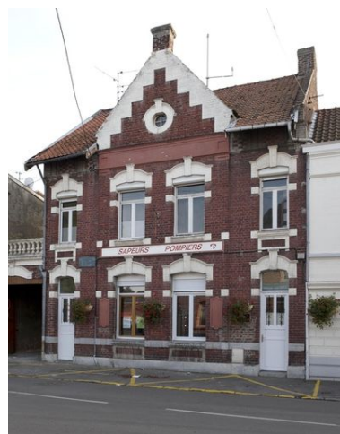
Elévation antérieure de la Poste, actuellement siège des Sapeurs-Pompiers.
