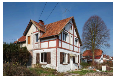
Maison à deux unités d'habitation à toiture débordante, rue Brûlée.
