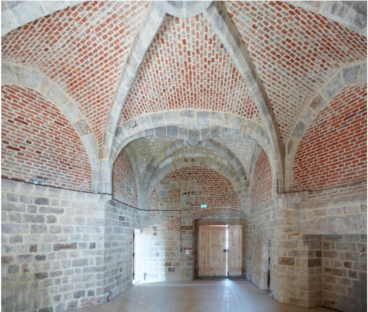
Vue en détail du premier niveau, vers le nord.
