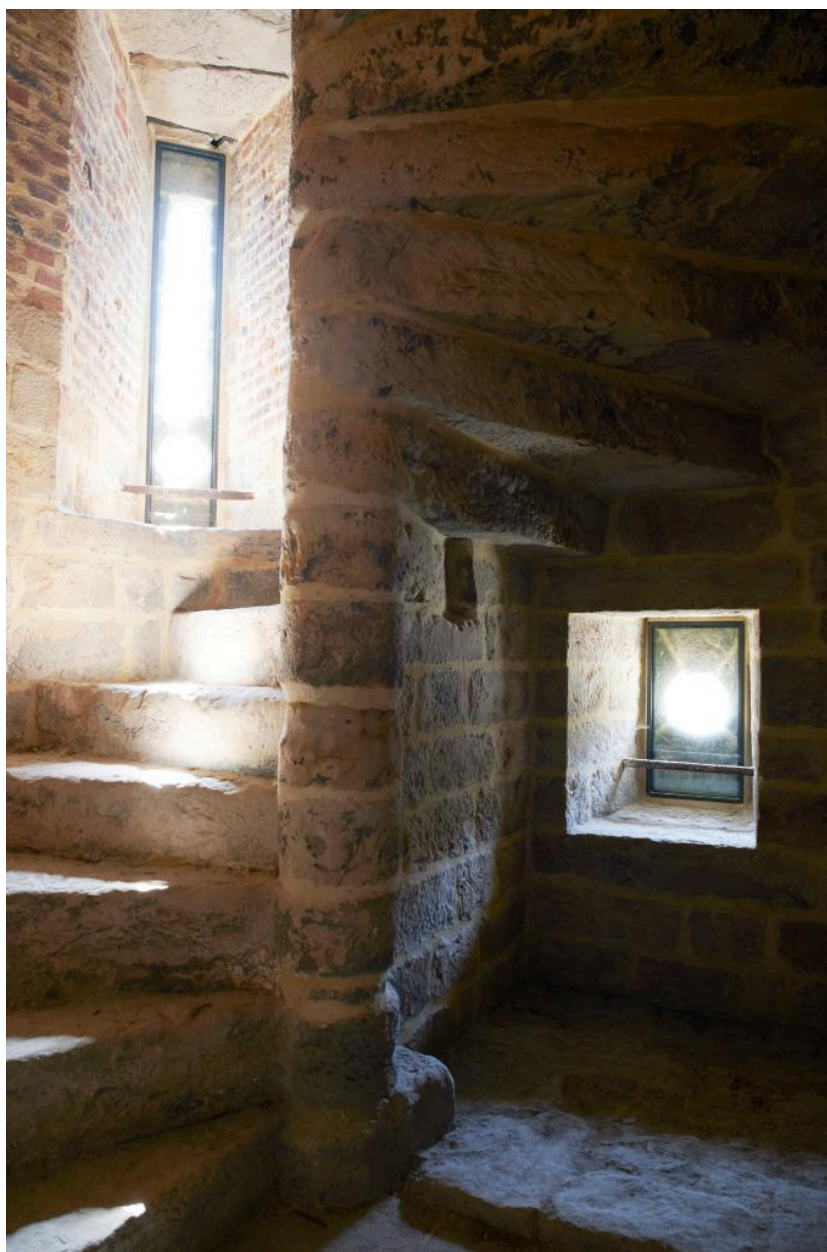
Vue générale des escaliers en grès prise depuis le premier niveau et menant à la terrasse supérieure.
