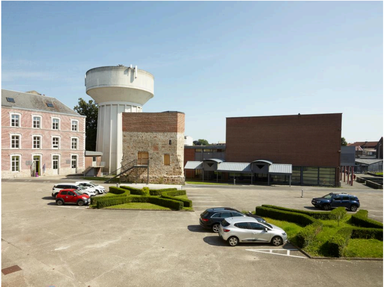
Vue générale du nord de la tour, prise depuis la cour du lycée.
