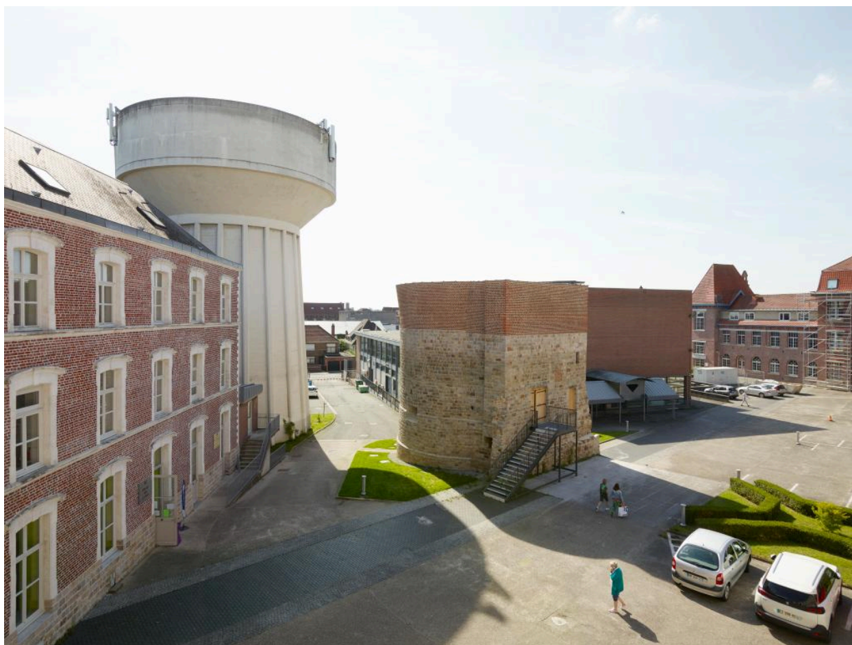
Vue générale du nord-est de la tour et du château d'eau, prise depuis les étages du lycée.
