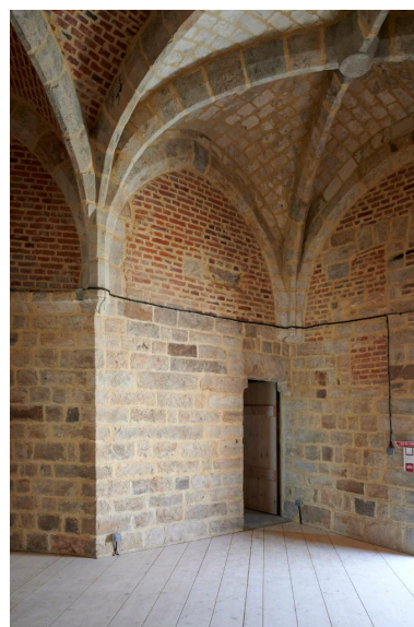
Vue générale de l'ouverture menant aux escaliers de la terrasse supérieure au nord du premier niveau. Phot. Delphine Volto-Jourdan IVR32_20216200882NUCA
