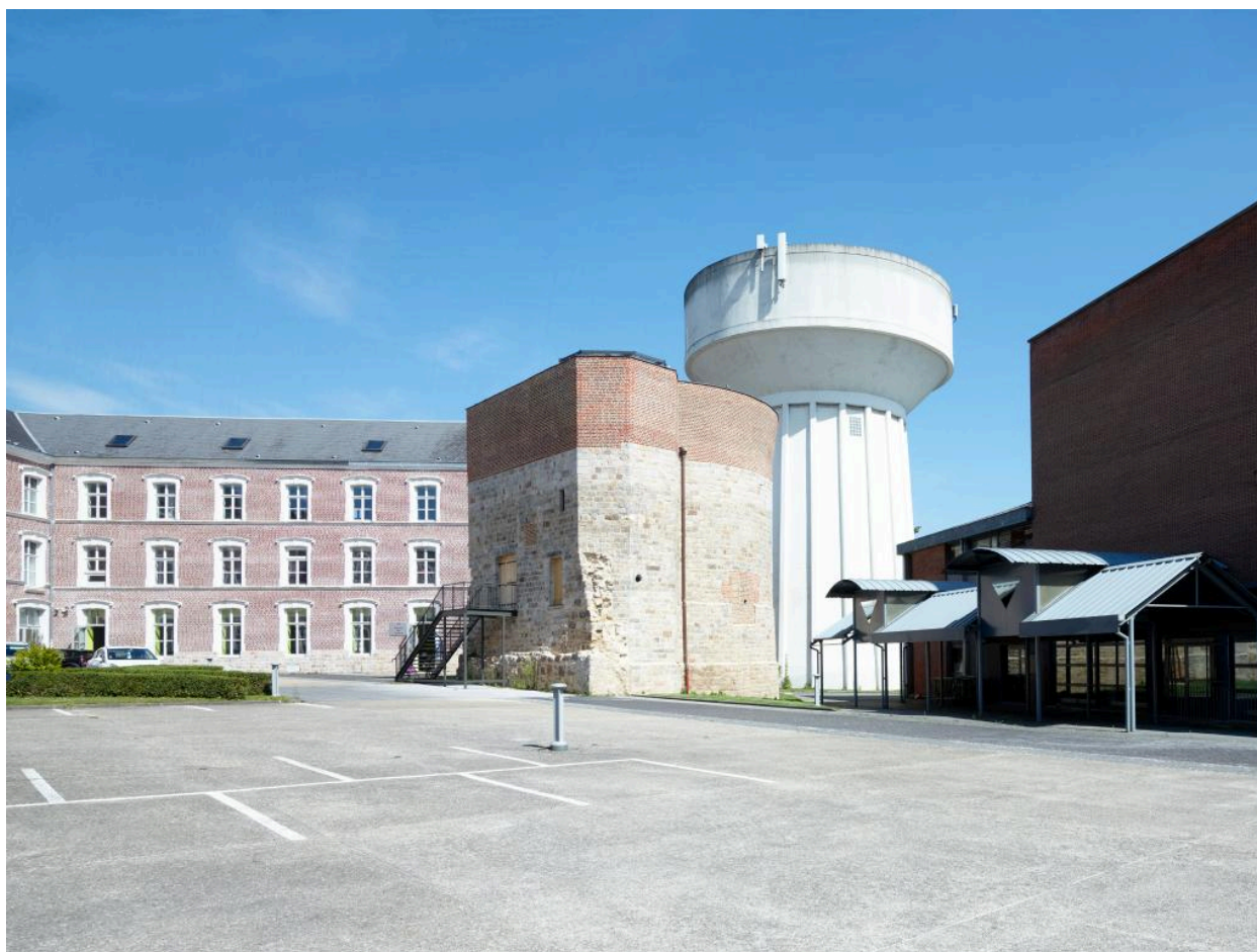
Vue générale du nord-ouest de la tour, prise depuis la cour du lycée.
