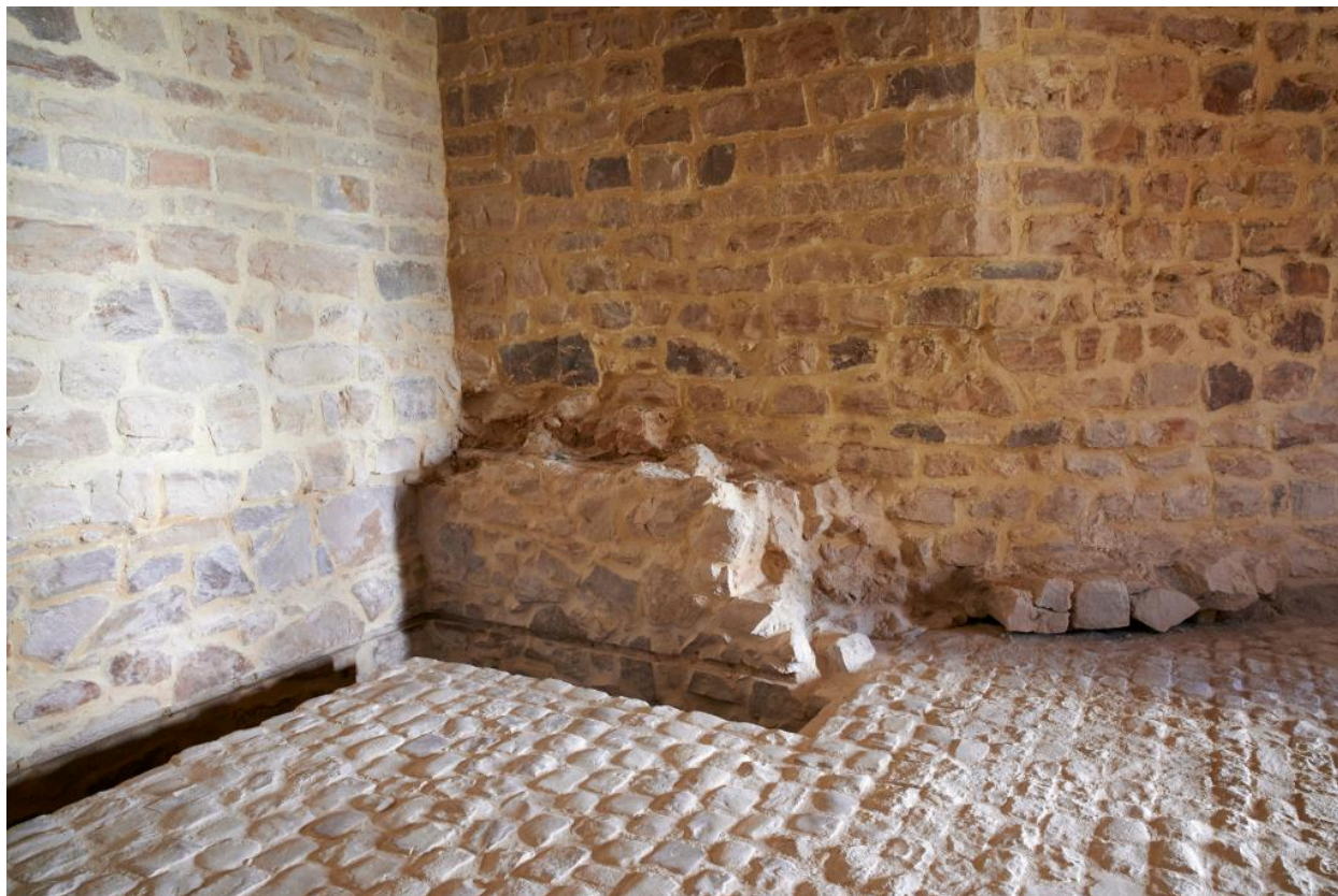
Vue de détail du rez-de-chaussée, observation du vestige des fondations médiévales.
