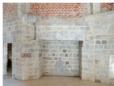
Vue en détail de la cheminée en grès, premier niveau. Phot. Delphine Volto-Jourdan IVR32_20216200878NUCA
