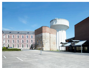
Vue générale du nord-ouest de la tour, prise depuis la cour du lycée. Phot. Delphine Volto-Jourdan IVR32_20216200891NUCA
