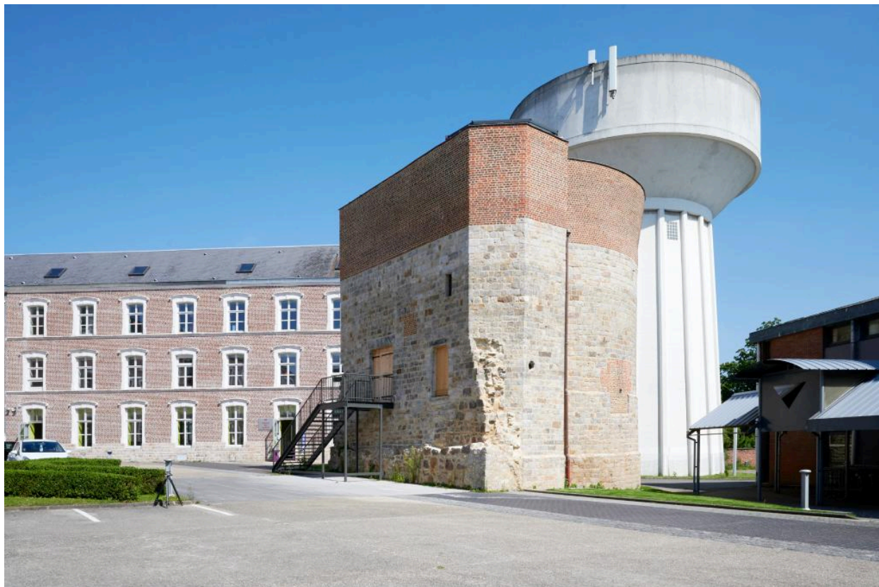
Vue générale du nord-est de la tour, prise depuis la cour du lycée.
