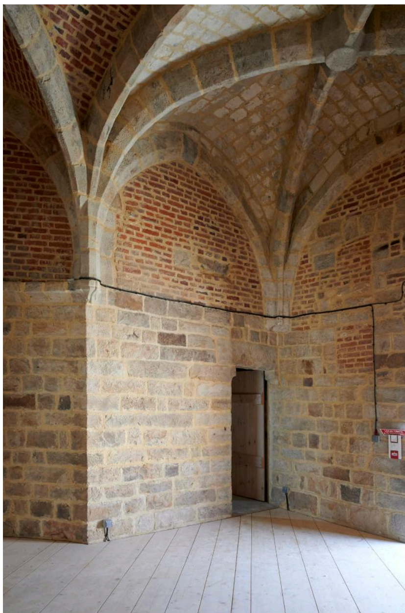
Vue générale de l'ouverture menant aux escaliers de la terrasse supérieure au nord du premier niveau.
