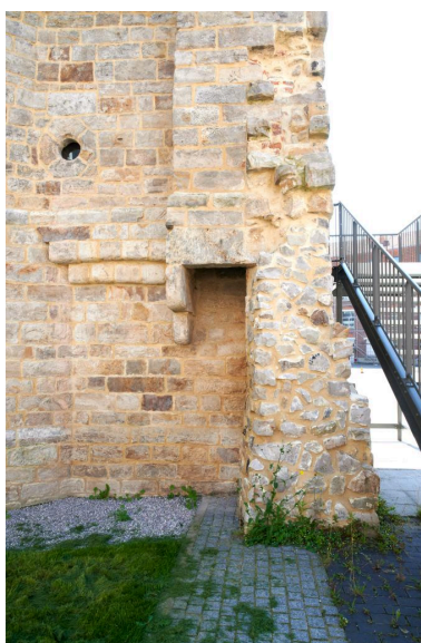
Vue en détail de la sortie extérieure des latrines sur la face est. Phot. Delphine Volto-Jourdan IVR32_20216200880NUCA
