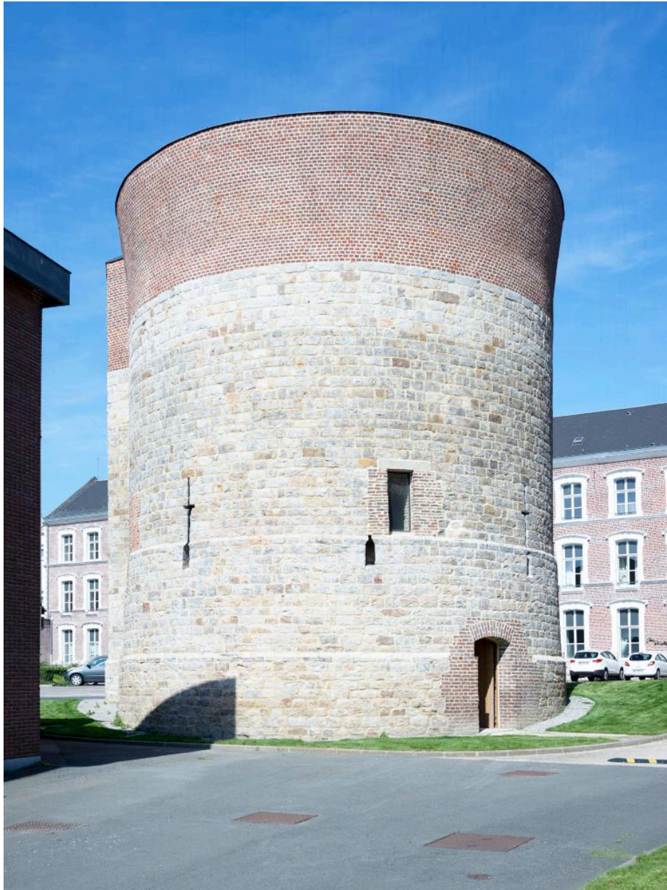
Vue générale du sud-est, prise depuis le parking.
