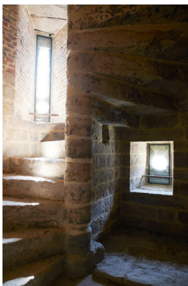
Vue générale des escaliers en grès prise depuis le premier niveau et menant à la terrasse supérieure. Phot. Delphine Volto-Jourdan IVR32_20216200884NUCA
