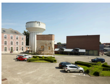
Vue générale du nord de la tour, prise depuis la cour du lycée. Phot. Delphine Volto-Jourdan IVR32_20216200896NUCA
