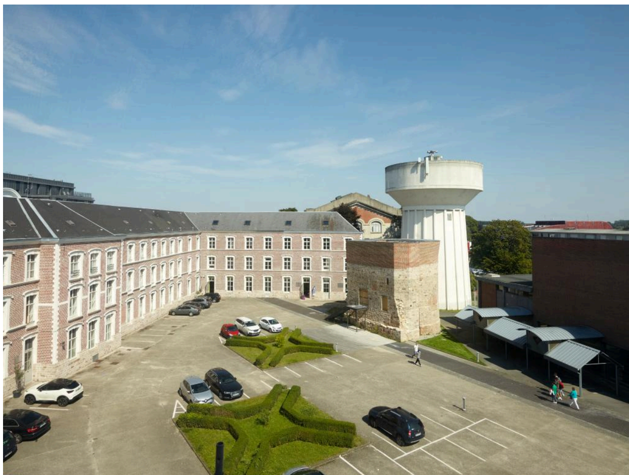
Vue générale du nord-ouest de la tour, prise depuis les étages du lycée.
