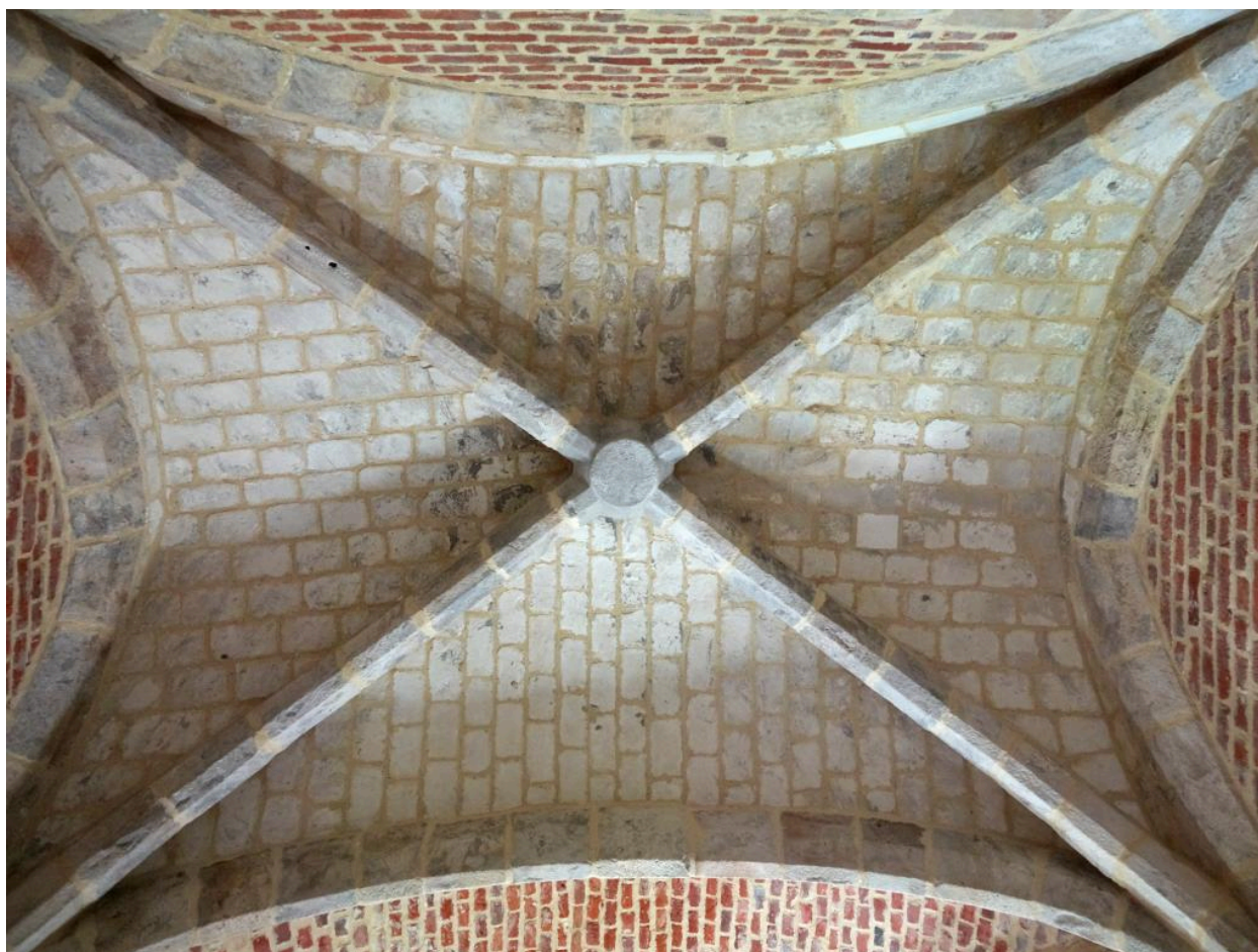
Vue de détail de la voûte nord sur croisée d'ogives, premier niveau.
