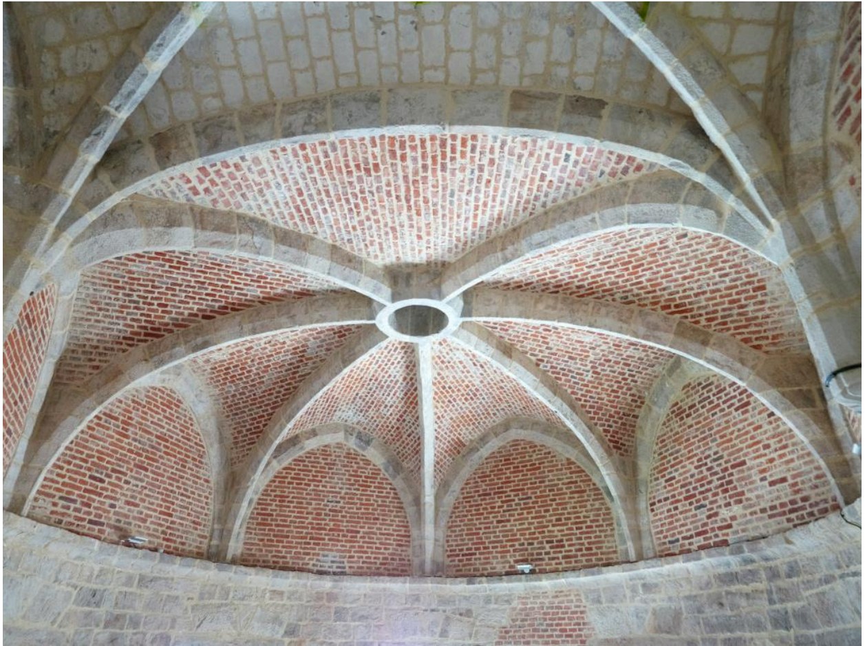
Vue de détail de la voûte sud sur croisée d'ogives et formerets, premier niveau.
