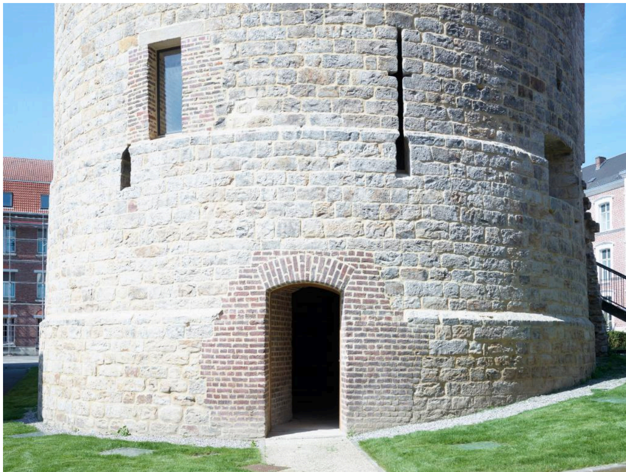
Vue de détail du sud-est.
