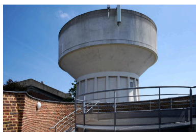
Vue générale de la terrasse supérieure, et du château d'eau à proximité directe. Phot. Delphine Volto-Jourdan IVR32_20216200886NUCA
