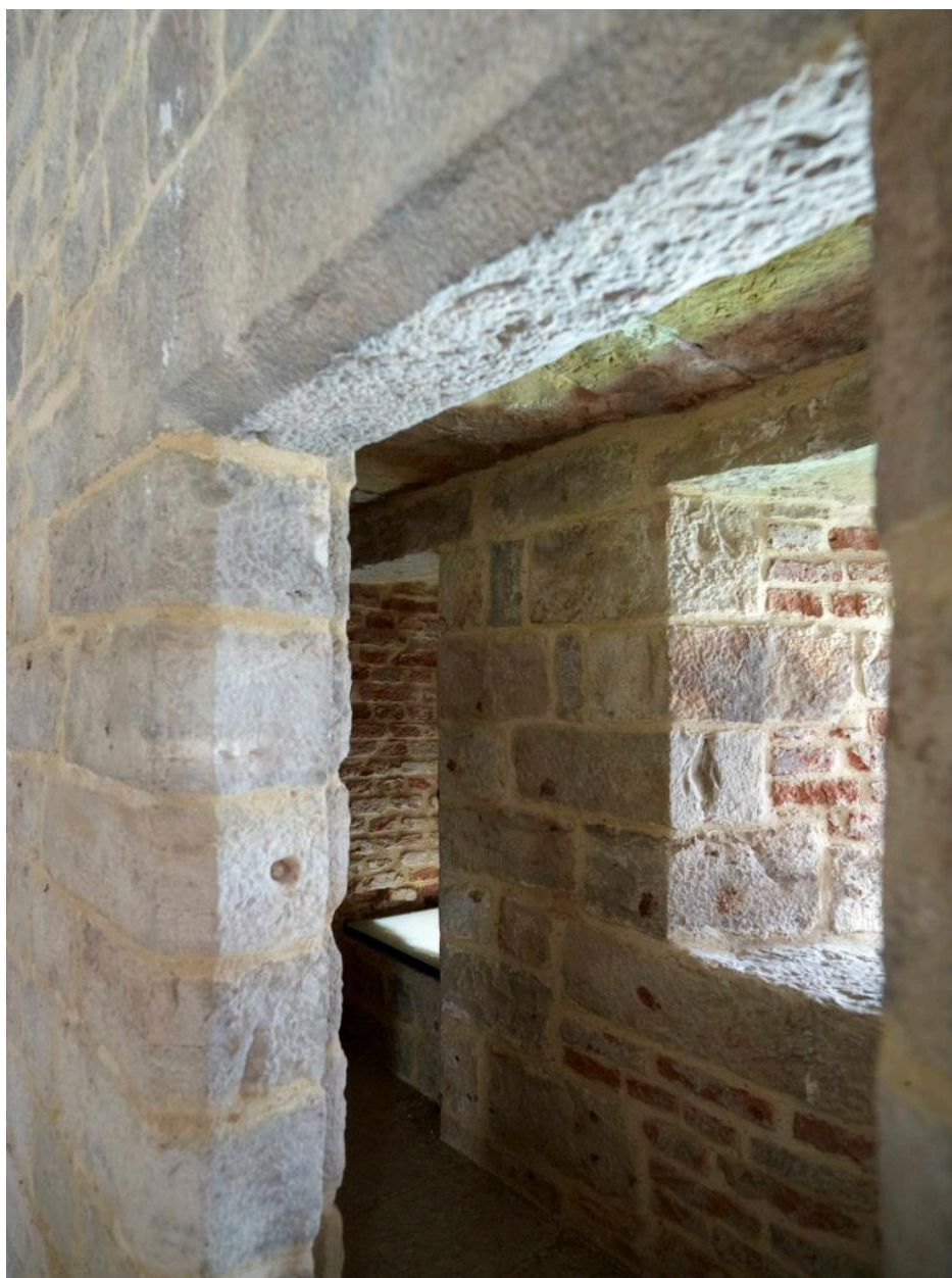
Vue de détail de l'accès aux latrines situées à l'est du premier niveau.
