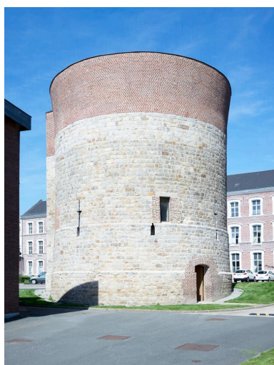
Vue générale du sud-est, prise depuis le parking. Phot. Delphine Volto-Jourdan IVR32_20216200865NUCA
