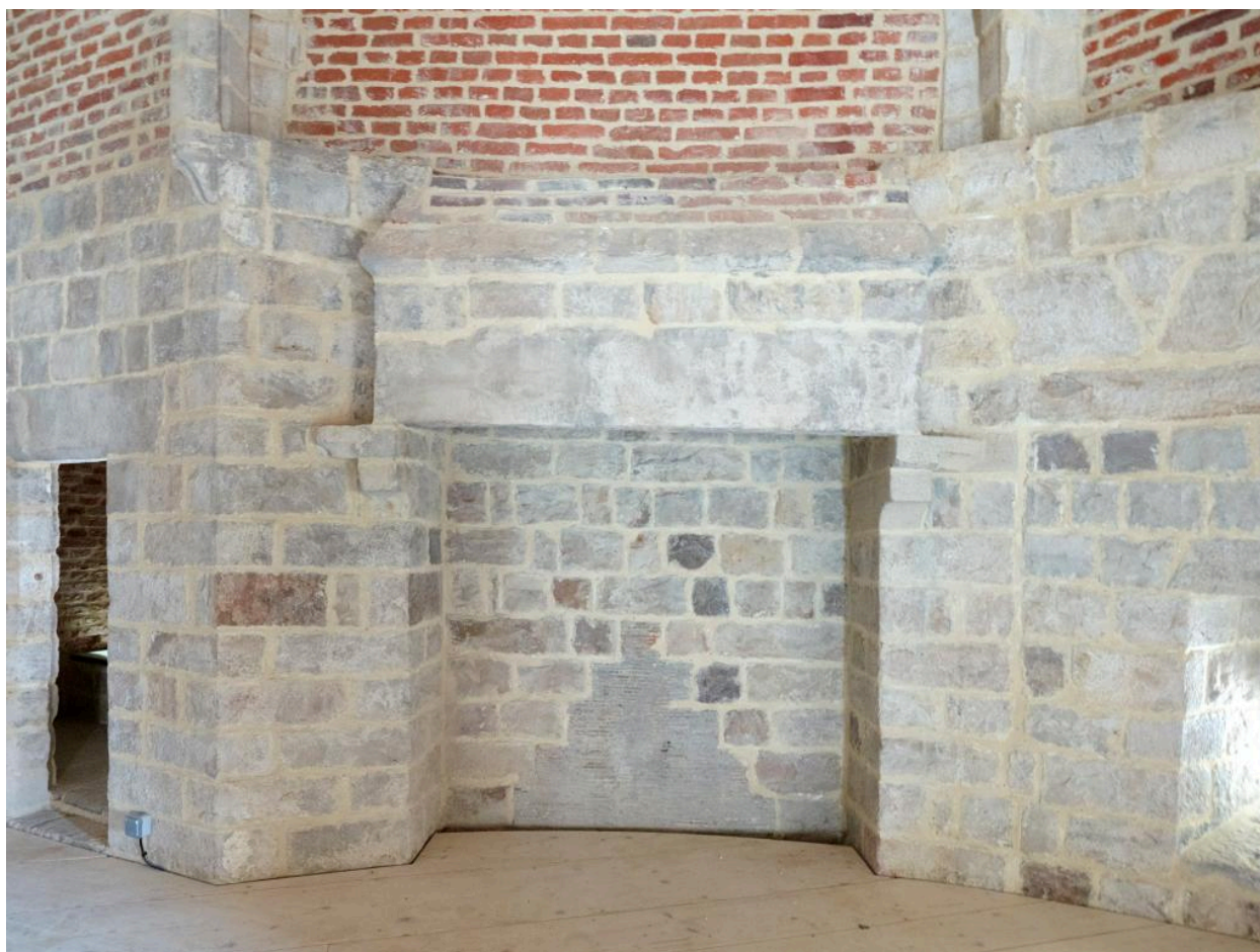
Vue en détail de la cheminée en grés, premier niveau.
