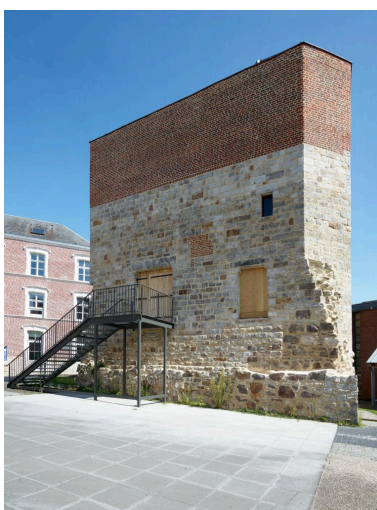
Vue général du nord de la tour prise depuis la cour du lycée. Cette vue permet de visualiser une section du rempart auquel est accolée la tour. Phot. Delphine Volto-Jourdan IVR32_20216200893NUCA
