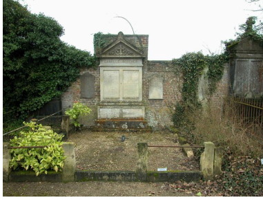
Vue générale. Phot. Laurent Nicolas IVR22_20058002244NUCA
