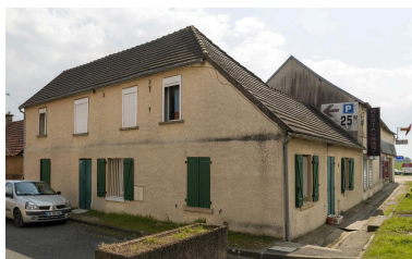
Logis sur la parcelle de l'ancienne auberge, vue depuis le nord. Phot. Marc Kérignard IVR32_20216000307NUCA
