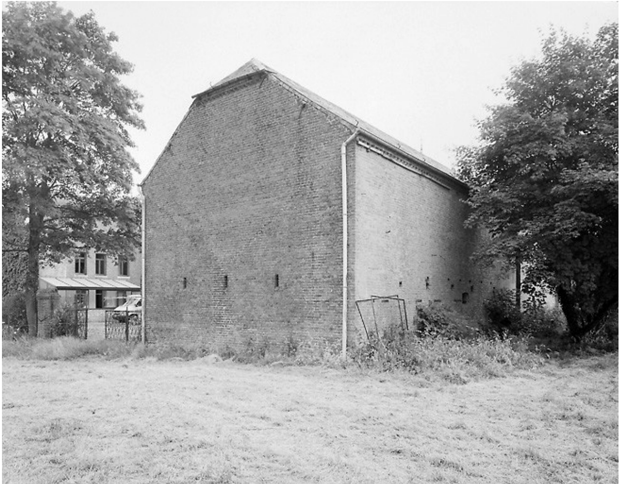
Vue du pignon de la grange.
