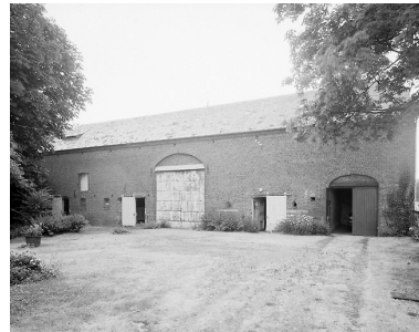
Vue générale de la grange, des étables et du fenil, depuis la cour. Phot. Pierre Thibaut IVR31_20055900640V
