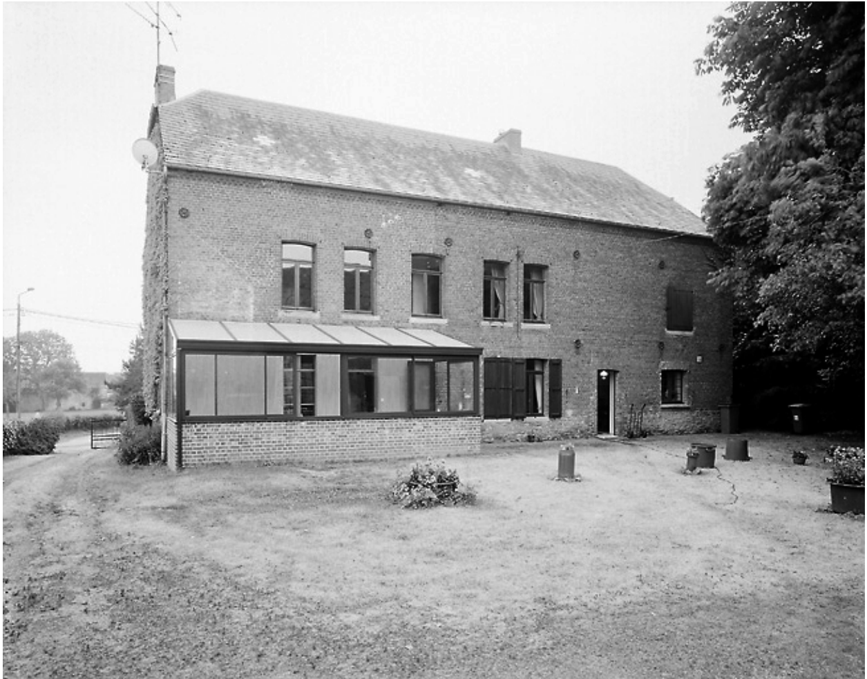
Vue générale de l'élévation postérieure du logis.
