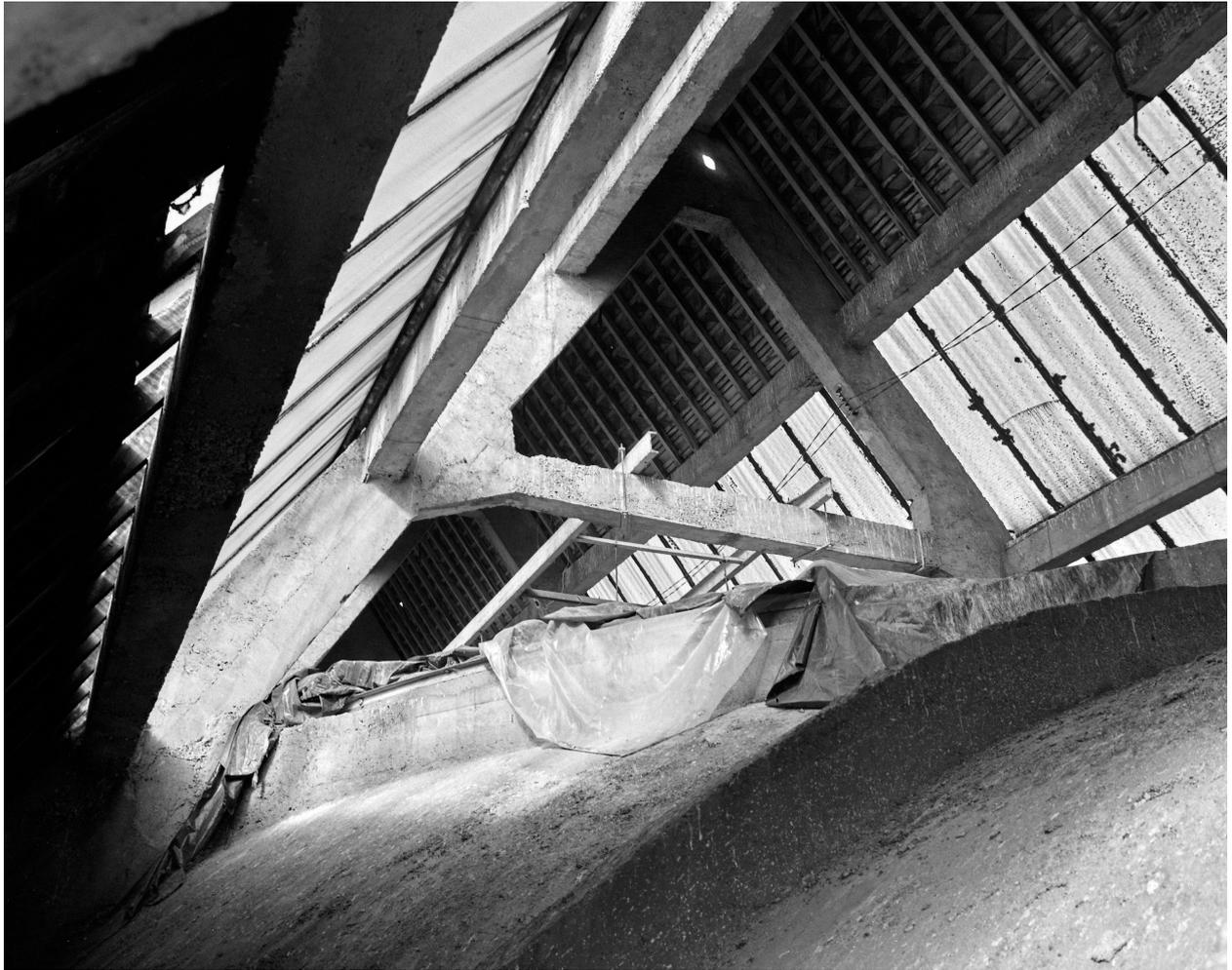
Niveau des combles : charpente en béton et plafond vitré de la salle de bal (recouvert d'une bâche).
