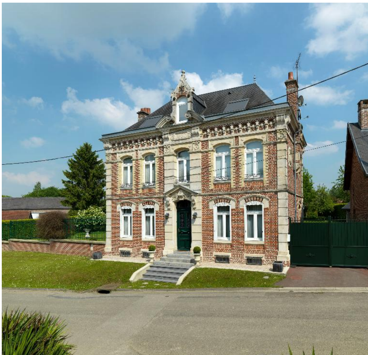
Vue d'ensemble sur rue.
