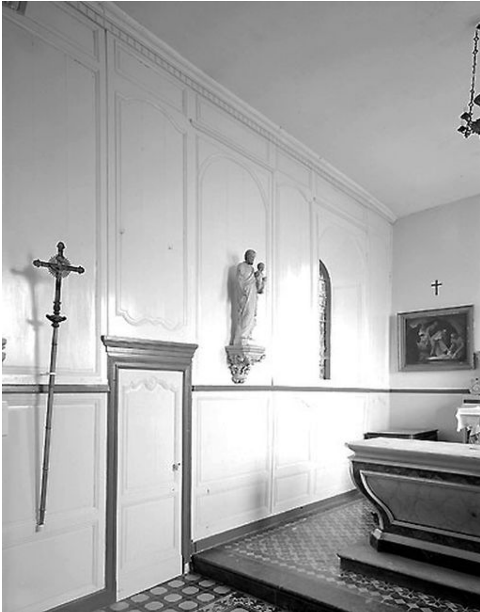
Vue générale du mur nord du choeur.
