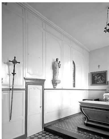
Vue générale du mur nord du chœur.
