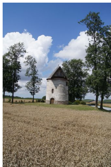
Vue générale. Phot. Marie-Laure Monnehay-Vulliet IVR22_20118000416NUCA
