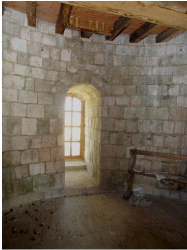
Vue intérieure. Phot. Isabelle Barbedor IVR22_20108010159NUCA
