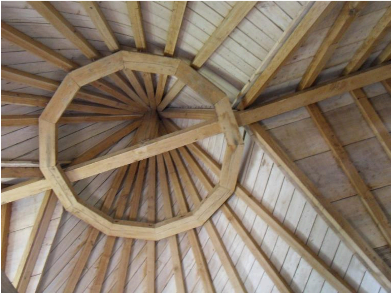
Vue de la charpente.
