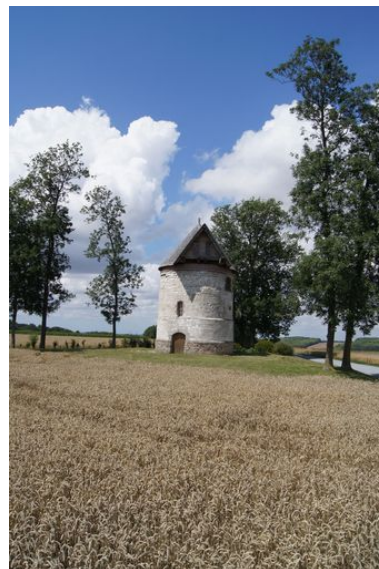
Vue générale. Phot. Marie-Laure Monnehay-Vulliet IVR22_20118000416NUCA
