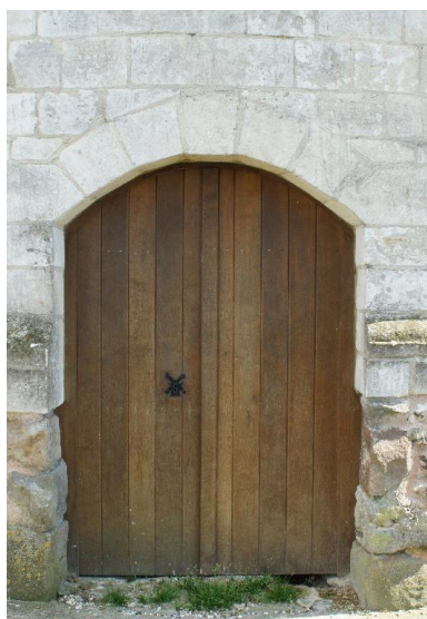
Vue de détail sur la porte du moulin. Phot. Marie-Laure Monnehay-Vulliet IVR22_20118000439NUC2A
