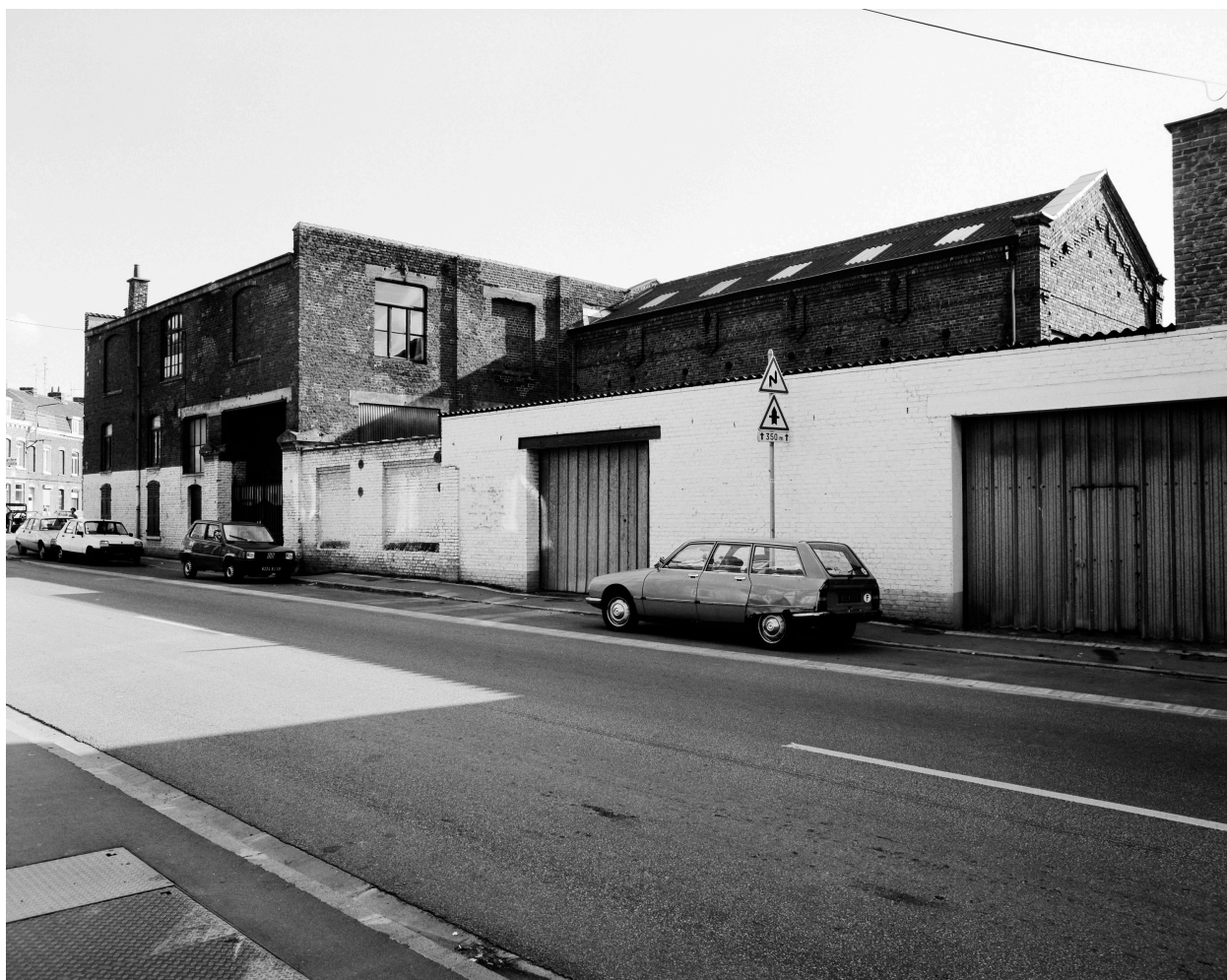
Atelier de fabrication, élévation rue Roger-Salengro.
