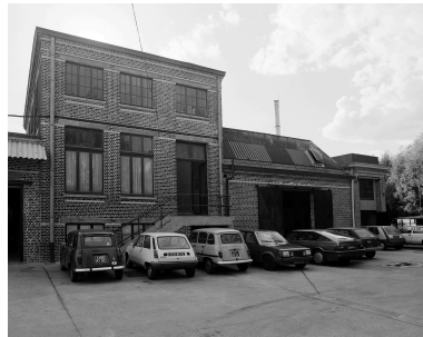
Bureaux, élévation sur cour. Phot. Olivier Marlard IVR31_19905900973X
