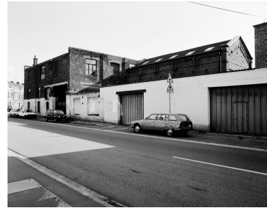
Atelier de fabrication, élévation rue Roger-Salengro. Phot. Olivier Marlard IVR31_19905900933X
