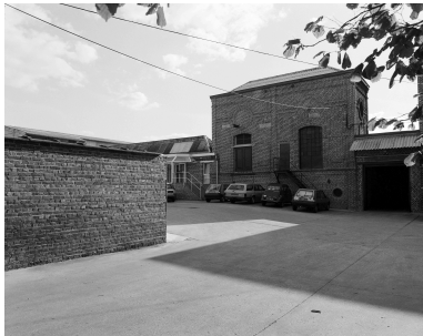
Salle des machines, élévation sur cour. Phot. Olivier Marlard IVR31_19905900972X
